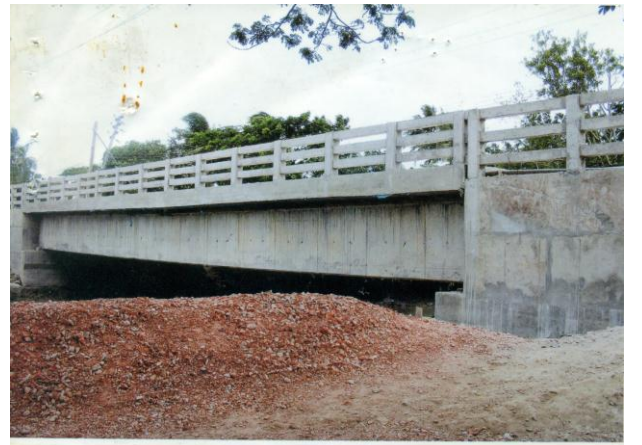
রক্ষণাবেক্ষণ খাতের আওতায় নির্মিত বরগুনা সড়ক বিভাগাধীন পটুয়াখালী-আমতলী-বরগুনা-কাকচিড়া সড়কের ৪৯তম কিলোমিটারে ২৮.০০ মিটার দীর্ঘ আরসিসি গার্ডার সেতু
