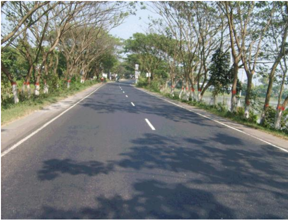
রক্ষণাবেক্ষণ খাতের আওতায় ঢাকা-মাওয়া মহাসড়কে ওভারলে কাজ
