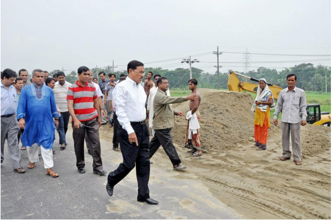
ঢাকা-চট্টগ্রাম ৪ লেনে উন্নীতকরণ প্রকল্প পরিদর্শন
