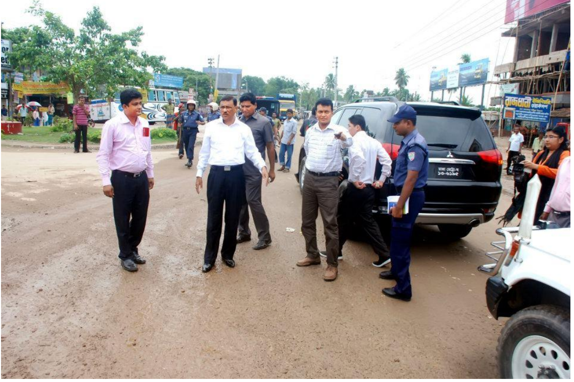
যশোর-খুলনা সড়ক নির্মাণ কাজ পরিদর্শন
