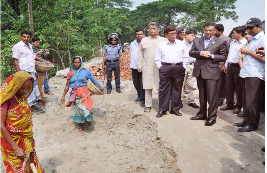
গোপালগঞ্জ সড়ক বিভাগের সড়ক নির্মাণ কাজ পরিদর্শন
