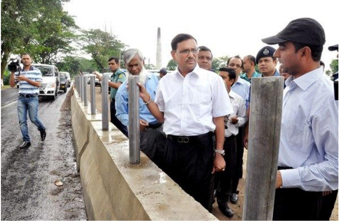
ঢাকা-আরিচা মহাসড়কের সড়ক বাঁক প্রশস্তকরণ কাজ পরিদর্শন
