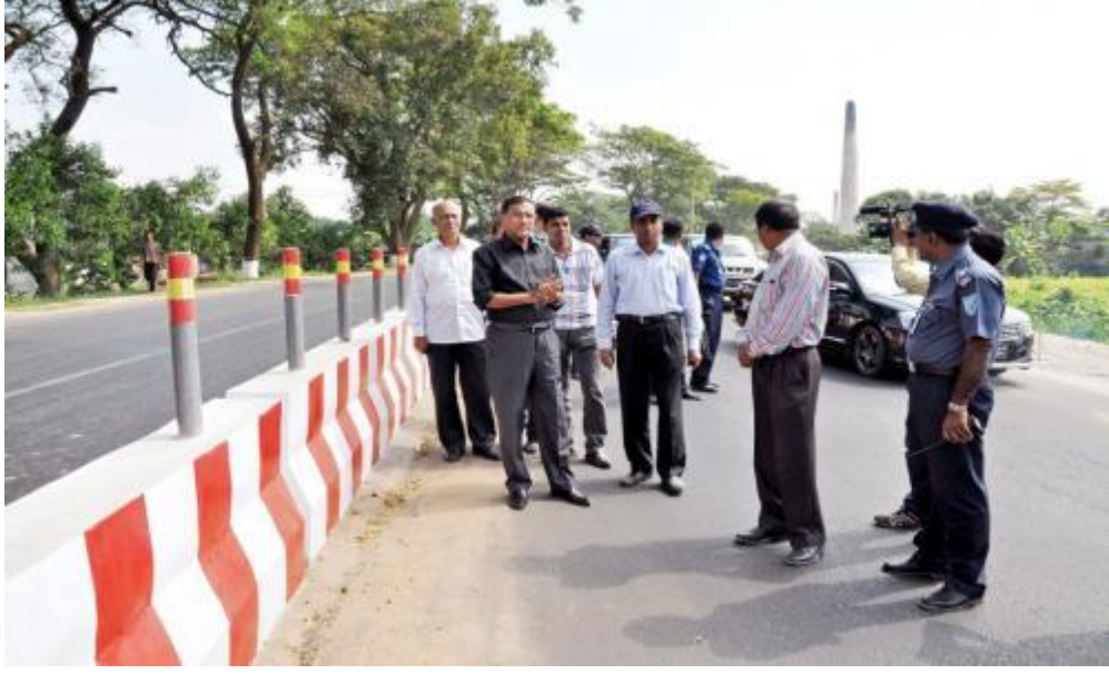
মাননীয় যোগাযোগ মন্ত্রী ঢাকা-আরিচা মহাসড়কে বাক সরলীকরণের বাস্তবায়ন কাজ পরিদর্শন করছেন
