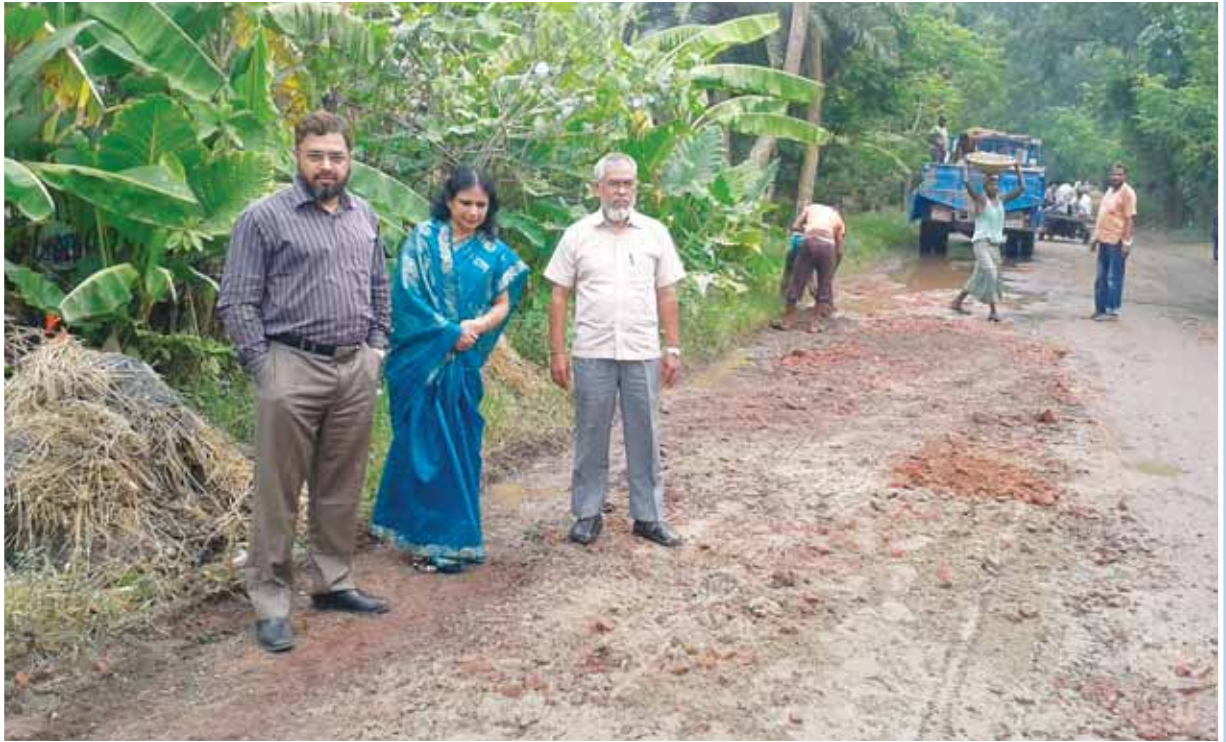
সড়ক পরিবহন ও মহাসড়ক বিভাগের মনিটরিং টিম-২১ এর প্রধান রওশন আরা বেগম ও সদস্যগণ কর্তৃক চাপাইনবাবগঞ্জ সড়ক বিভাগের আওতাধীন চাপাইনবাবগঞ্জ-আমনুরা মহাসড়কের রক্ষণাবেক্ষণ কাজ পরিদর্শন
