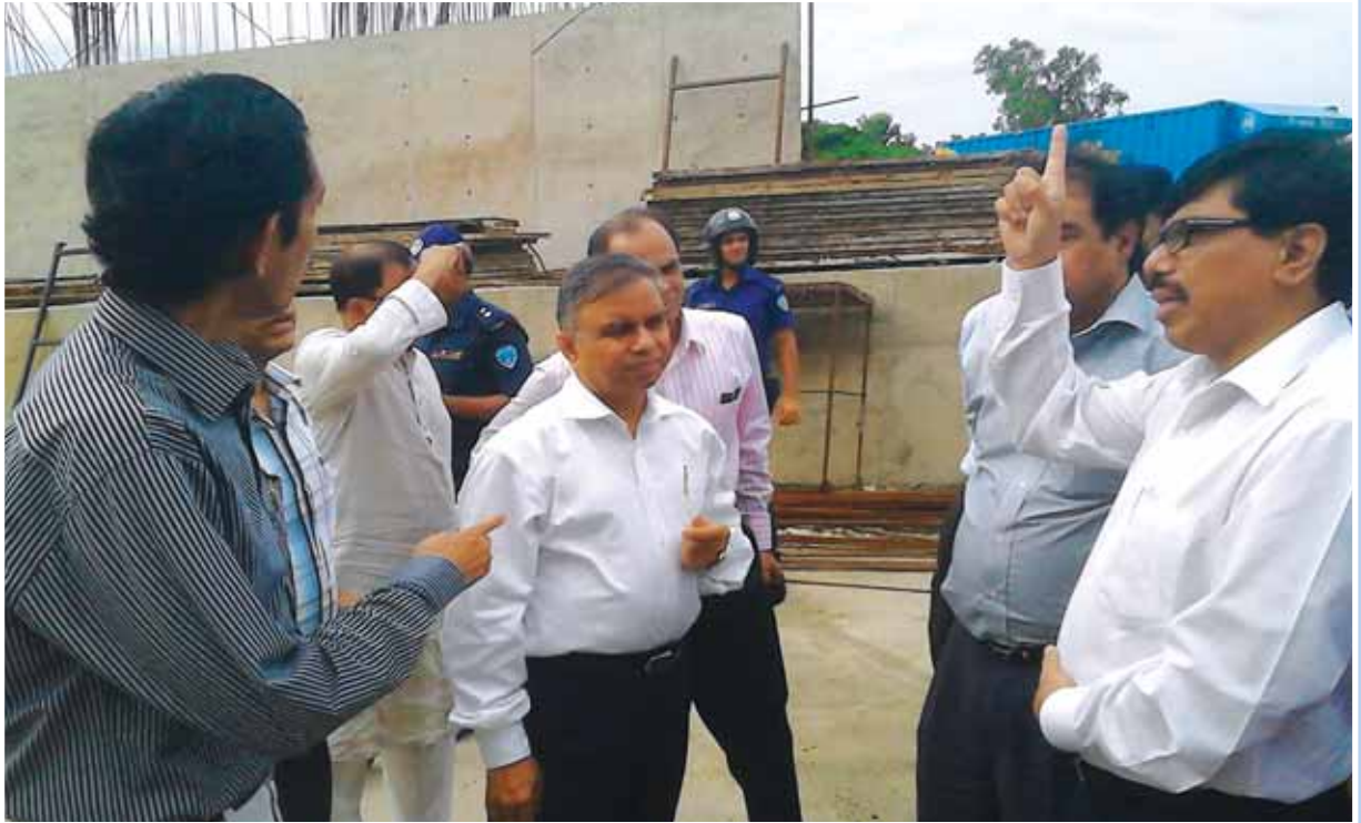
প্রধানমন্ত্রীর কার্যালয়ের মুখ্য সচিব জনাব মোঃ আবুল কালাম আজাদ সড়ক পরিবহন ও মহাসড়ক বিভাগের অতিরিক্ত সচিব জনাব মোঃ ফারুক জলীলকে সাথে নিয়ে ঢাকা-চট্টগ্রাম মহাসড়কে নির্মাণাধীন মহিপাল ফ্লাইওভার এর কাজ পরিদর্শন করছেন
