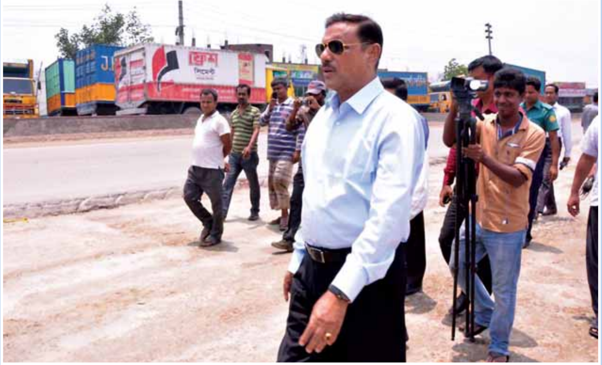
মাননীয় সড়ক পরিবহন ও সেতু মন্ত্রী জনাব ওবায়দুল কাদের কর্তৃক যাত্রাবাড়ী-কাঁচপুর মহাসড়ক (পোল্ডার রোড) চ-লেনে উন্নীতকরণের কাজ পরিদর্শন
