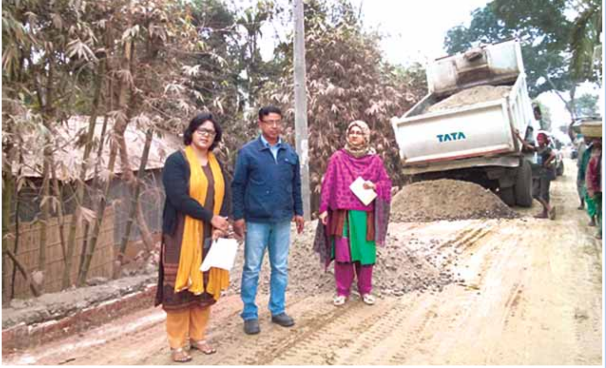
সড়ক পরিবহন ও মহাসড়ক বিভাগের মনিটরিং টিম-১৭ এর প্রধান আলিম রুদাবা ও সদস্যগণ কর্তৃক রাজবাড়ী-বাগমারা-জৌকুড়া মহাসড়কের নির্মাণ কাজ পরিদর্শন
