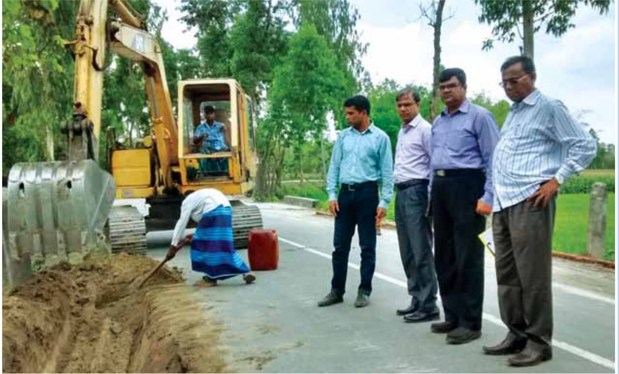
সড়ক পরিবহন ও মহাসড়ক বিভাগের মনিটরিং টিম-২৫ এর প্রধান জনাব পরিতোষ হাজরা ও সদস্যগণ কর্তৃক নীলফামারী সড়ক বিভাগের আওতাধীন জলঢাকা-ডিমলা মহাসড়কের পিএমপি কাজ পরিদর্শন
