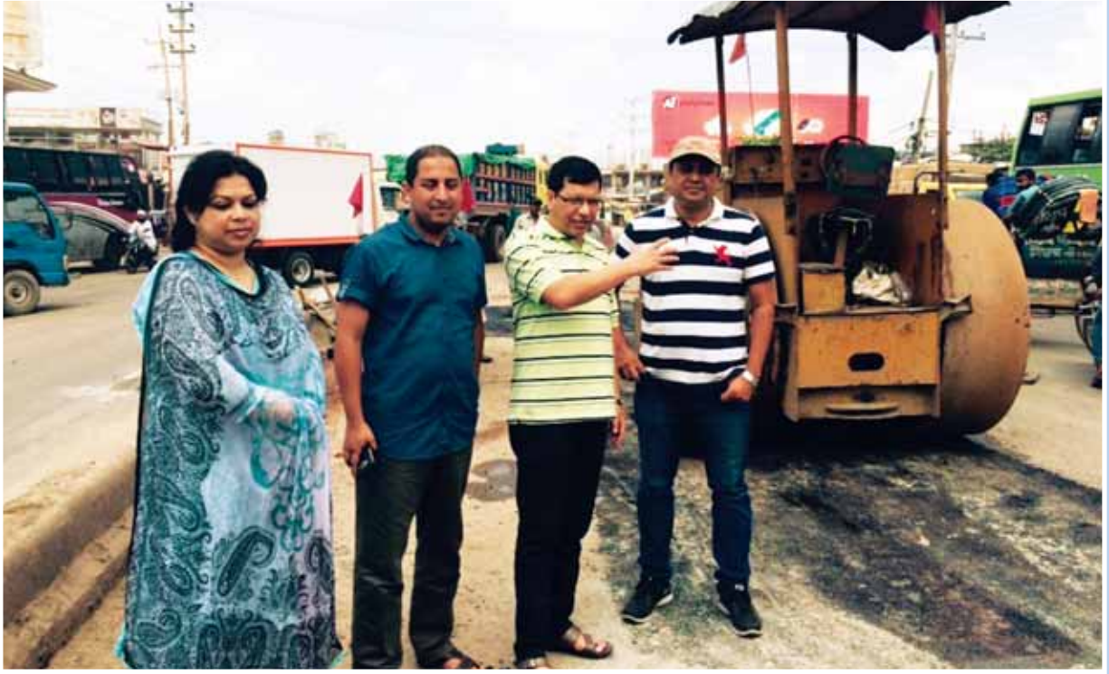
সড়ক পরিবহন ও মহাসড়ক বিভাগের মনিটরিং টিম-১ এর প্রধান জনাব সফিকুল ইসলাম ও সদস্যগণ কর্তৃক নবীনগর-ডিইপিজেড-চন্দ্রা মহাসড়ক ৪-লেনে উন্নীতকরণের কাজ পরিদর্শন
