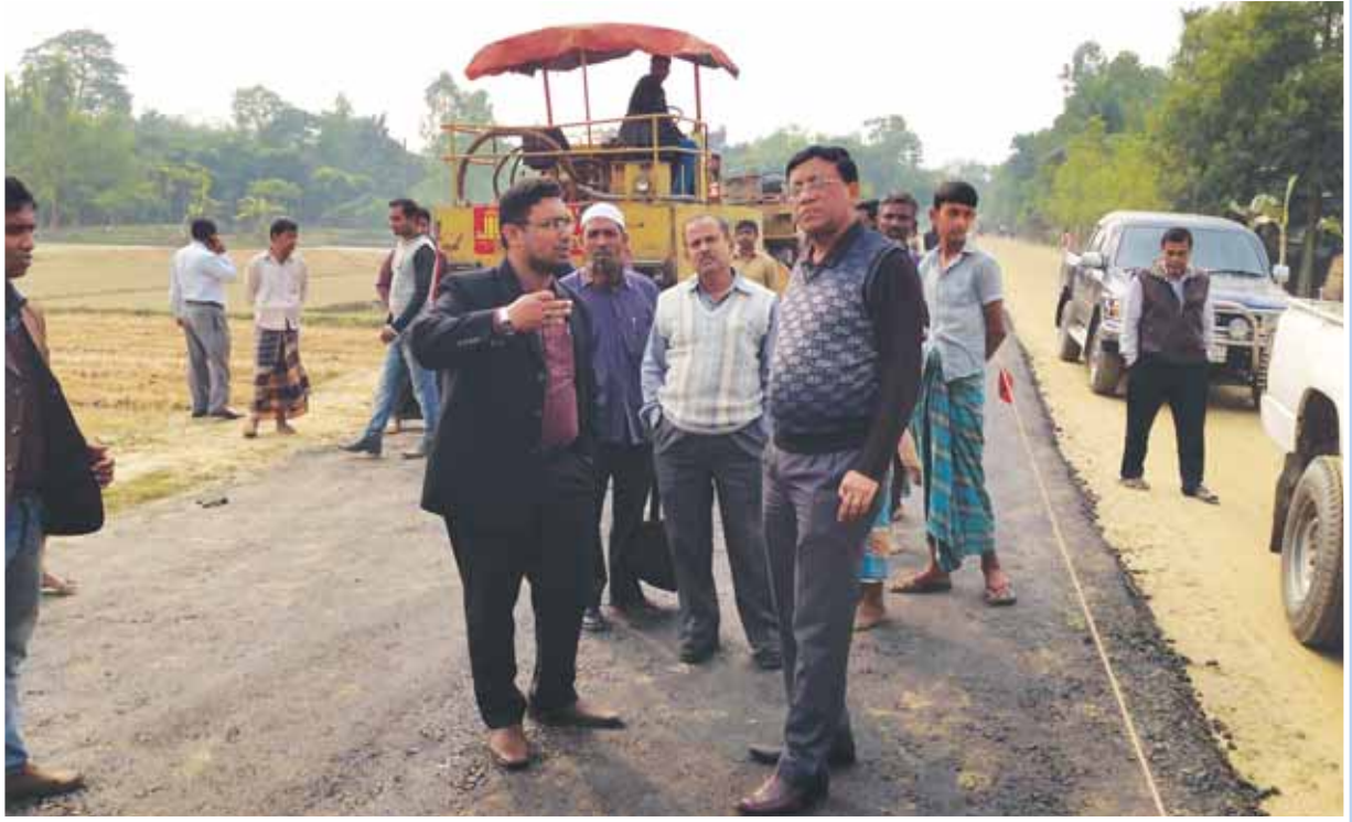
সড়ক পরিবহন ও মহাসড়ক বিভাগের মনিটরিং টিম-৫ এর প্রধান জনাব মোঃ সামছুল করিম ভূঁইয়া ও সদস্যগণ কর্তৃক নলকা-নকুগাঁও মহাসড়কের উন্নয়ন কাজ পরিদর্শন
