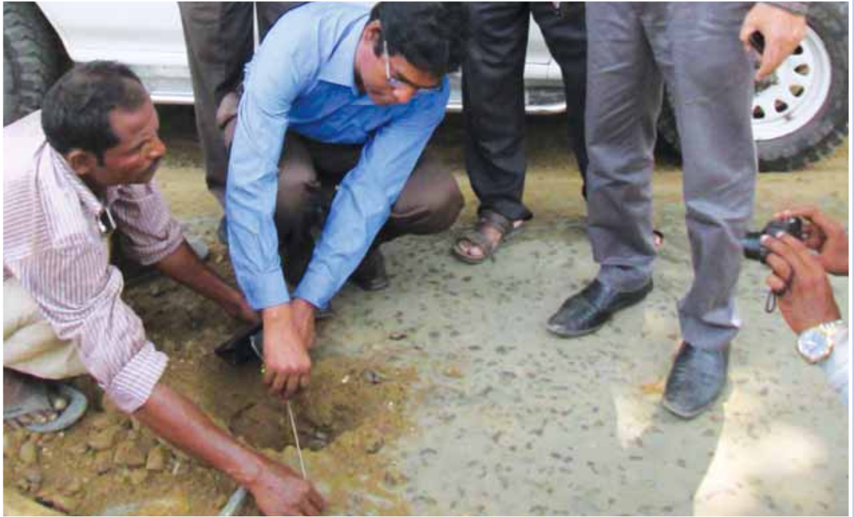
সড়ক পরিবহন ও মহাসড়ক বিভাগের মনিটরিং টিম-৬ কর্তৃক সরাইল-নাসিরনগর-লাখাই-হবিগঞ্জ মহাসড়কের মেরামত কাজ পরিদর্শন
