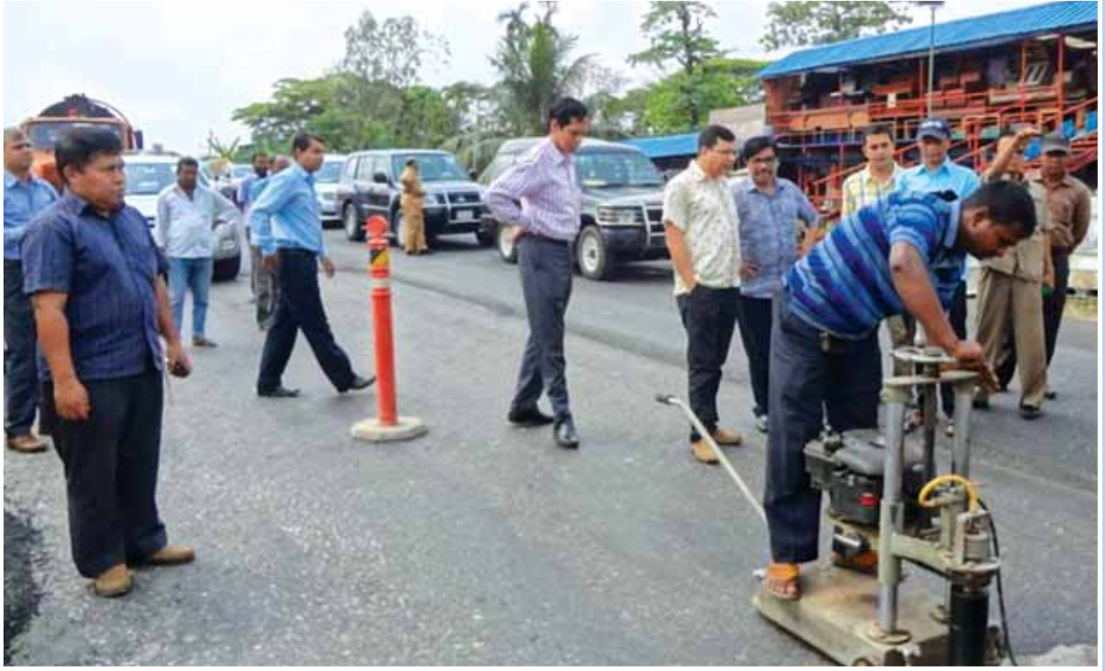
সড়ক পরিবহন ও মহাসড়ক বিভাগের অতিরিক্ত সচিব জনাব মোঃ ফারুক জলীল ঢাকা-চট্টগ্রাম মহাসড়ক ৪-লেনে উন্নীতকরণ প্রকল্পের কাজ কোর কাটিং মেশিনের সাহায্যে যাচাই করছেন
