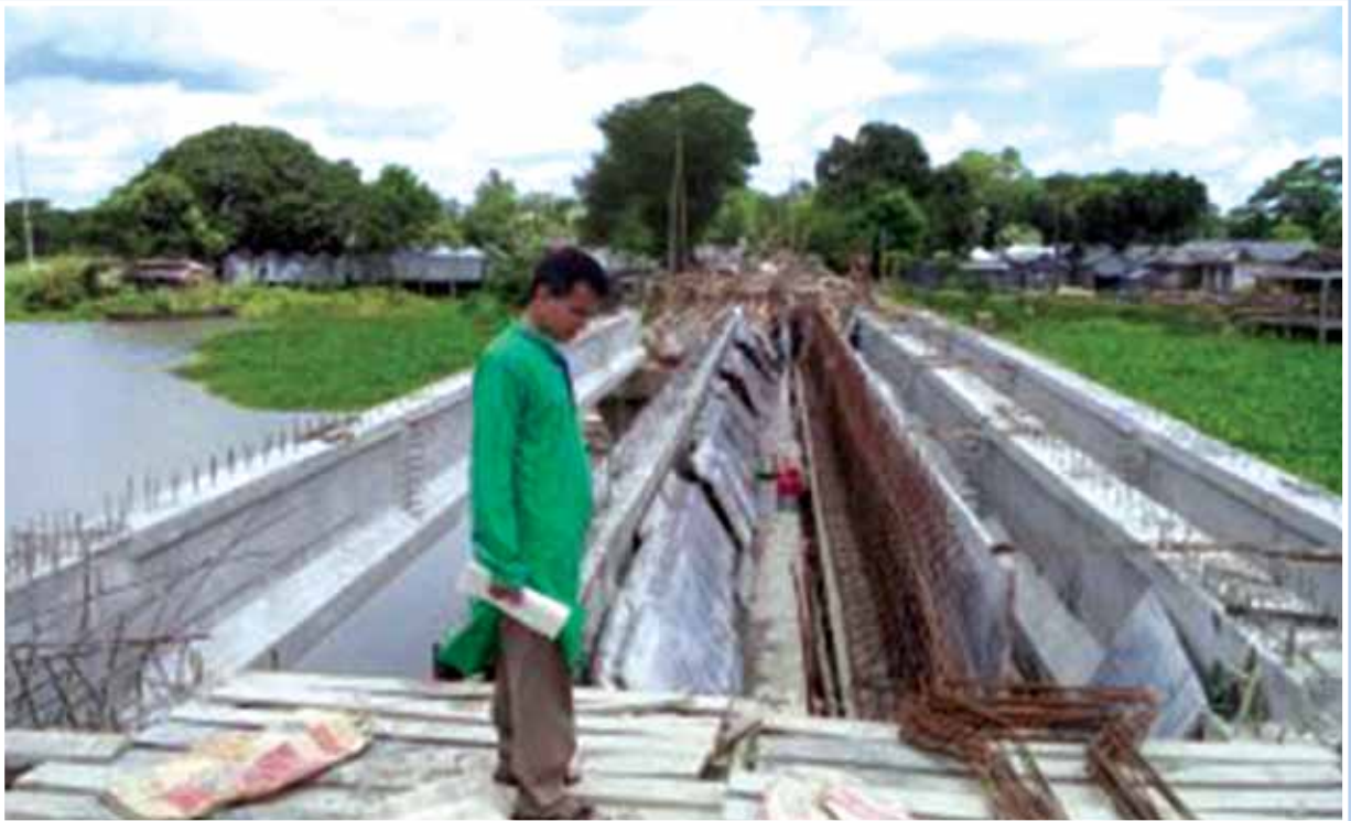
সড়ক পরিবহন ও মহাসড়ক বিভাগের মনিটরিং টিম-১৬ এর প্রধান জনাব মোঃ রবিউল ইসলাম ও সদস্যগণ কর্তৃক মাদারীপুর সড়ক বিভাগের আওতাধীন সাধুর ব্রীজের নির্মাণ কাজ পরিদর্শন
