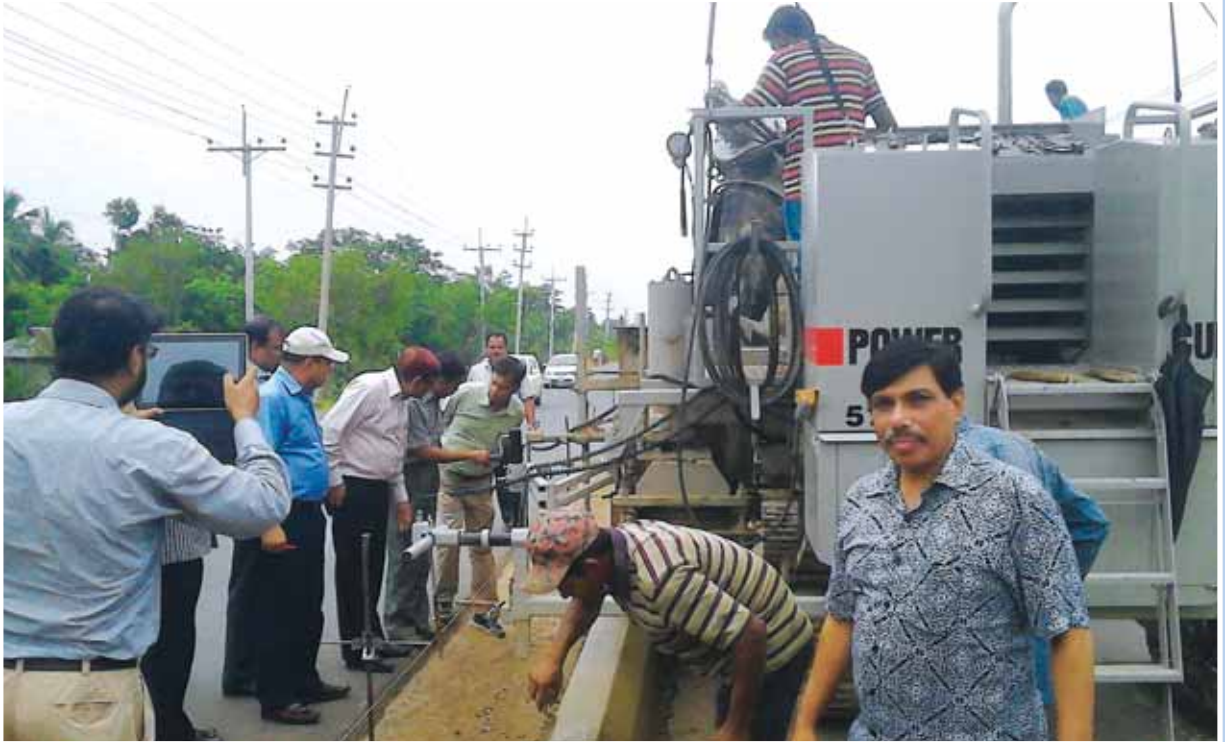
সড়ক পরিবহন ও মহাসড়ক বিভাগের অতিরিক্ত সচিব জনাব মোঃ ফারুক জলীল কর্তৃক জয়দেবপুর-ময়নসিংহ মহাসড়ক ৪-লেনে উন্নীতকরণের কাজ পরিদর্শন
