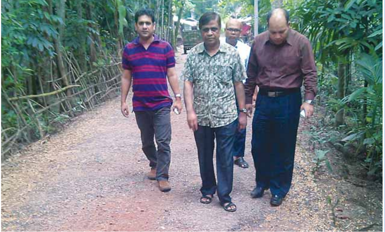
সড়ক পরিবহন ও মহাসড়ক বিভাগের মনিটরিং টিম-১৮ এর প্রধান জনাব মোঃ আব্দুল হামিদ ও সদস্যগণ কর্তৃক ভান্ডারিয়া-টৈকখালী-কাঠালিয়া (পিরোজপুর অংশ) মহাসড়কের ক্ষতিহস্ত অংশ পরিদর্শন
