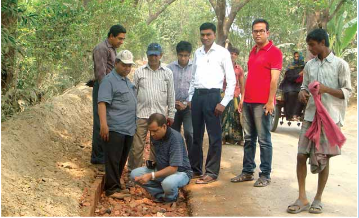
সড়ক পরিবহন ও মহাসড়ক বিভাগের মনিটরিং টিম-১৫ এর প্রধান জনাব মুহাম্মদ আউয়াল মোল্লা ও সদস্যগণ কর্তৃক চুয়াডাঙ্গা সড়ক বিভাগের দর্শনা-মুজিবনগর মহাসড়কের ৫তম কিলোমিটারে মাইনর পিএমপির আওতায় সড়ক প্রশস্থকরণের চলমান কাজ পরিদর্শন
