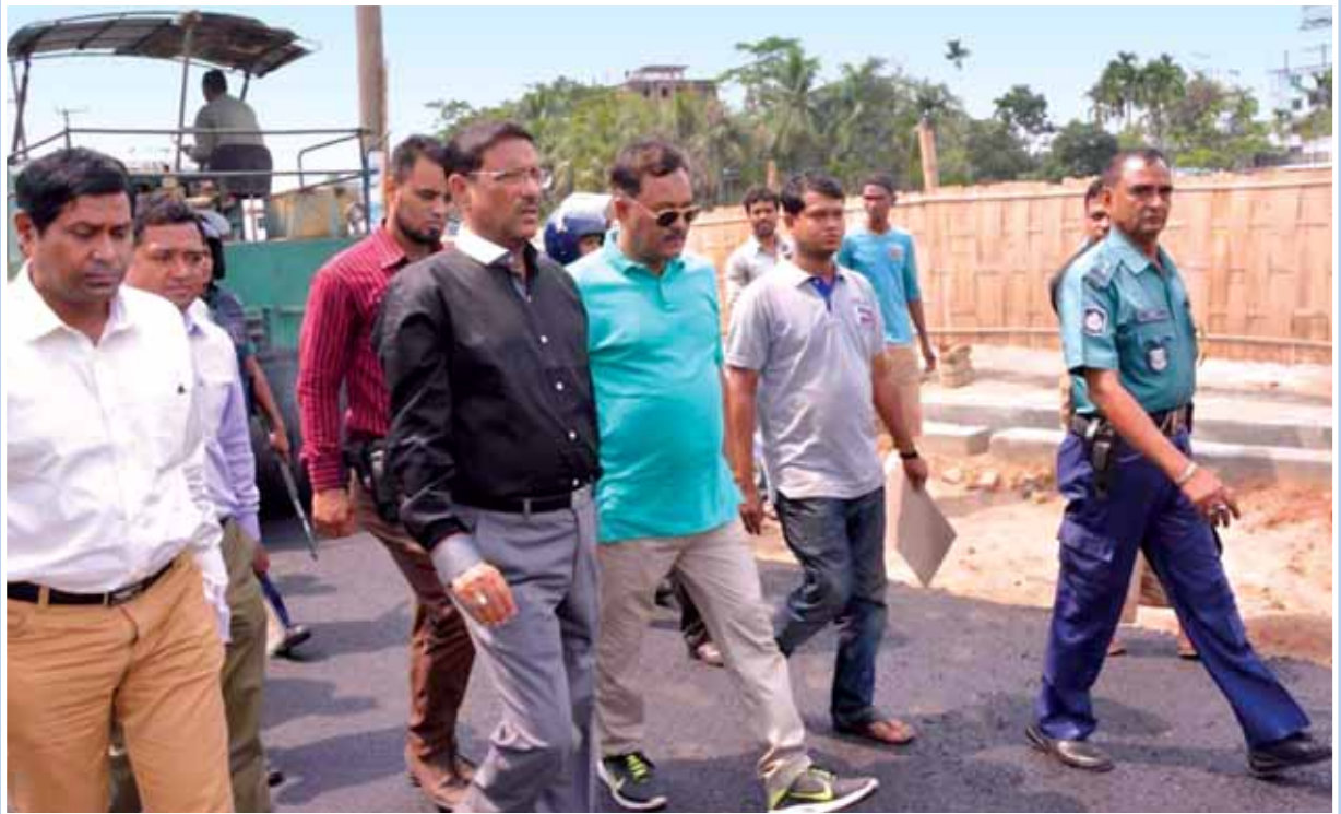
মাননীয় সড়ক পরিবহন ও সেতু মন্ত্রী জনাব ওবায়দুল কাদের কর্তৃক চট্টগ্রাম সড়ক বিভাগাধীন অঞ্জিজন মোড়-হাটহাজারি মহাসড়ক উন্নয়ন কাজ পরিদর্শন
