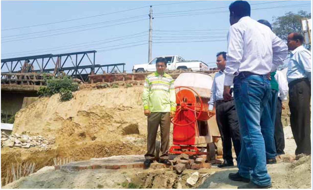
সড়ক পরিবহন ও মহাসড়ক বিভাগের মনিটরিং টিম-১৩ এর প্রধান জনাব মোঃ দেলোয়ার হোসেন ও সদস্যগণ কর্তৃক যশোর সড়ক বিভাগের পালবাড়ী-বোর্ডঅফিস-মনিহার সড়কে বাবলাতলা সেতুর নির্মাণ কাজ পরিদর্শন
