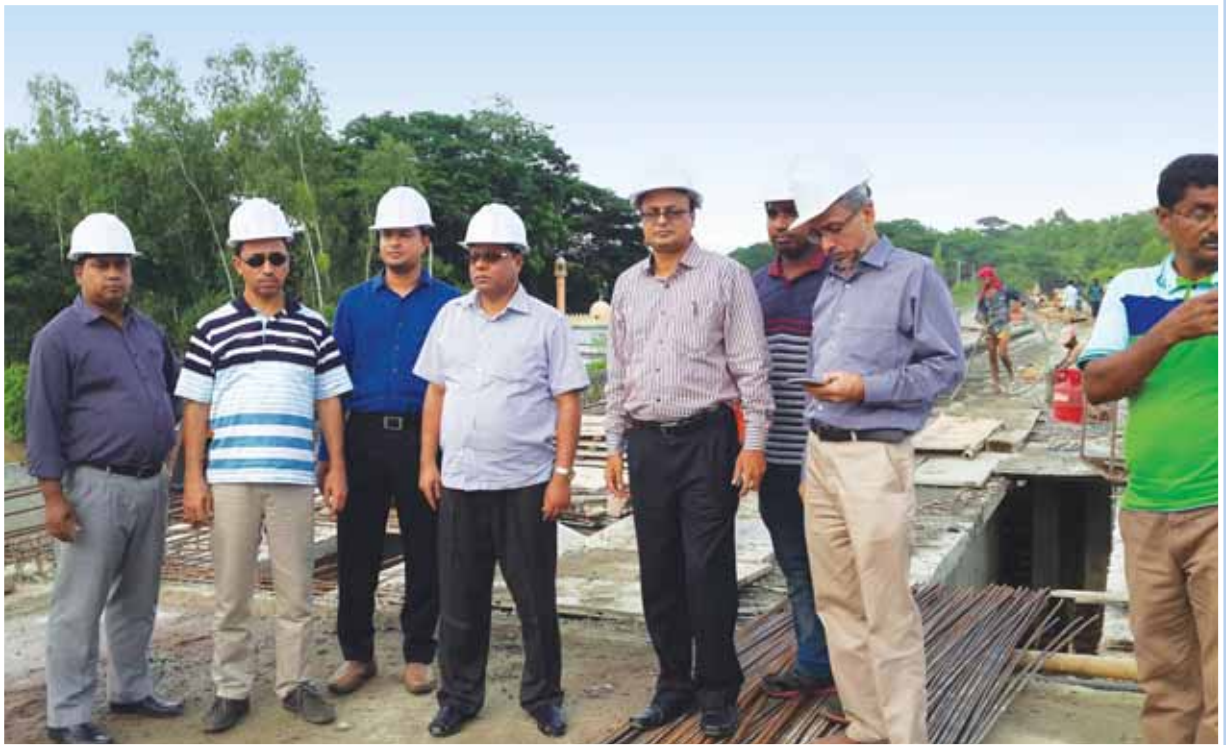
সড়ক পরিবহন ও মহাসড়ক বিভাগের মনিটরিং টিম-৮ এর প্রধান জনাব মোঃ আজহারুল ইসলাম খান ও সদস্যগণ কর্তৃক কক্সবাজার সড়ক বিভাগের আওতাধীন চকোরিয়া-বদরখালী মহাসড়কে বাটাখালী সেতুর নির্মাণ কাজ পরিদর্শন
