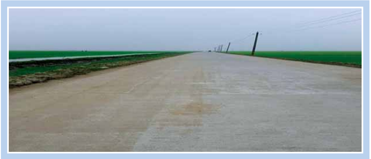
উজানচর-বাজিতপুর-অষ্টগ্রাম সাবমার্জিবল মহাসড়ক
