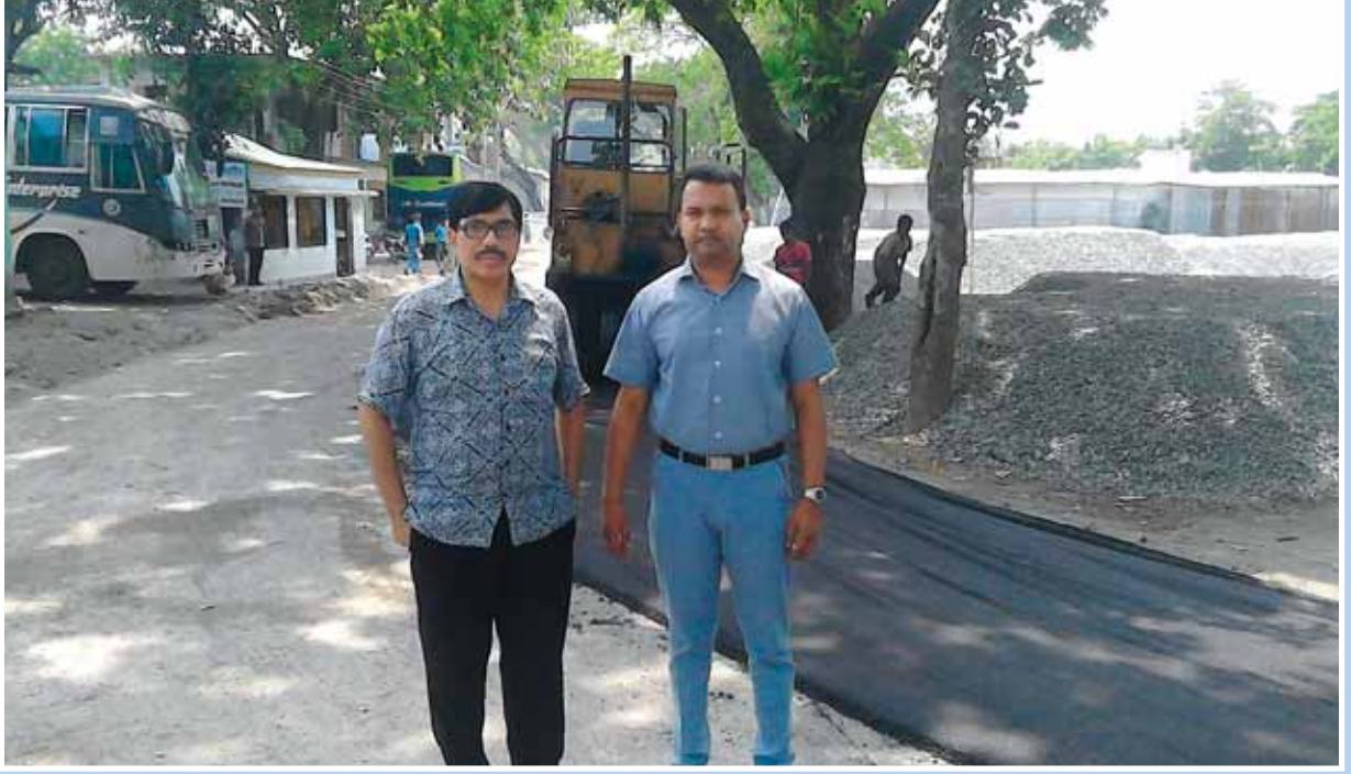
সড়ক পরিবহন ও মহাসড়ক বিভাগের অতিরিক্ত সচিব জনাব মোঃ ফারুক জলীল কর্তৃক লালমনিরহাট-পাটখাম মহাসড়কের রক্ষণাবেক্ষণ কাজ পরিদর্শন
