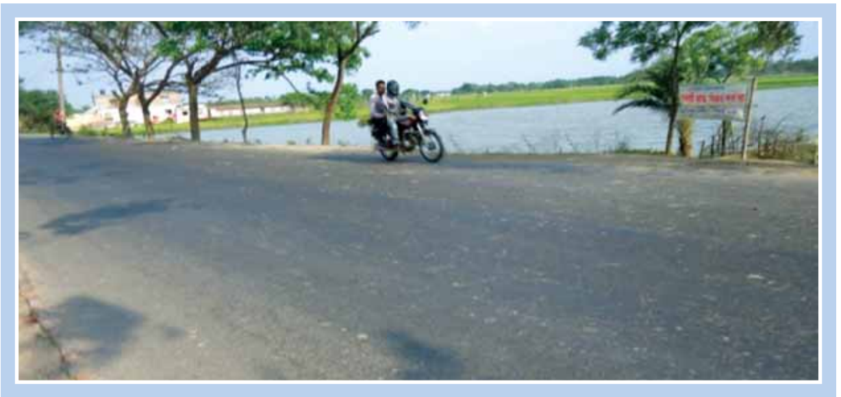
ভোমরা স্থলবন্দর সংযোগসহ সাতক্ষীরা শহর বাইপাস সড়ক নির্মাণ প্রকল্পের আওতায় নির্মিত আলীপুর-ভোমরা মহাসড়ক
