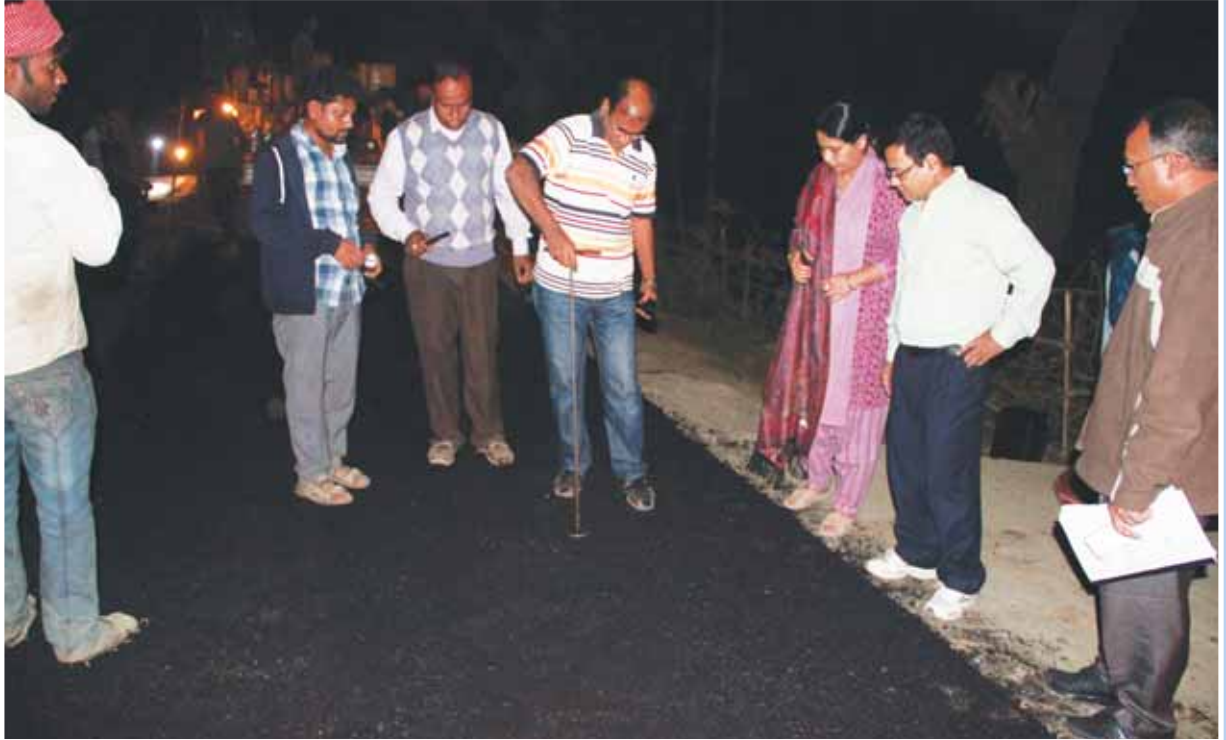
সড়ক পরিবহন ও মহাসড়ক বিভাগের মনিটরিং টিম-১০ এর প্রধান জনাব চন্দন কুমার দে ও সদস্যগণ কর্তৃক সিলেট-সুনামগঞ্জ মহাসড়কের রক্ষণাবেক্ষণ কাজ পরিদর্শন
