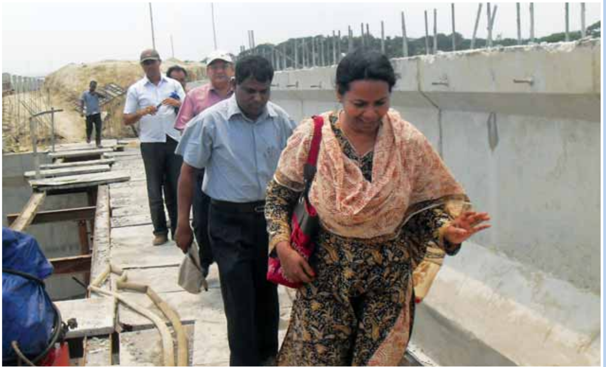
সড়ক পরিবহন ও মহাসড়ক বিভাগের মনিটরিং টিম-৪ এর প্রধান বেগম যাহিদা খানম ও সদস্যগণ কর্তৃক কিশোরগঞ্জ-করিমগঞ্জ-চামড়াঘাট-মিঠামইন মহাসড়কে নির্মাণাধীন সেতু পরিদর্শন
