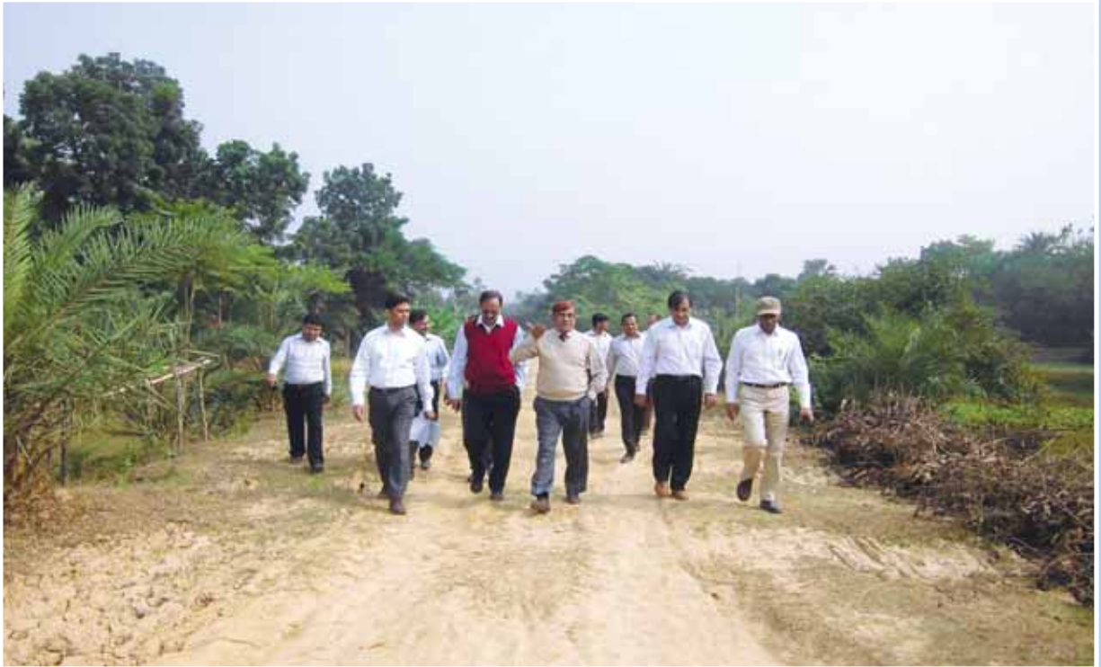
সড়ক পরিবহন ও মহাসড়ক বিভাগের সচিব জনাব এম, এ, এন, ছিদ্দিক গাজীপুর-আজমতপুর-ইটাখোলা মহাসড়কের নির্মাণ কাজ পরিদর্শন করছেন
