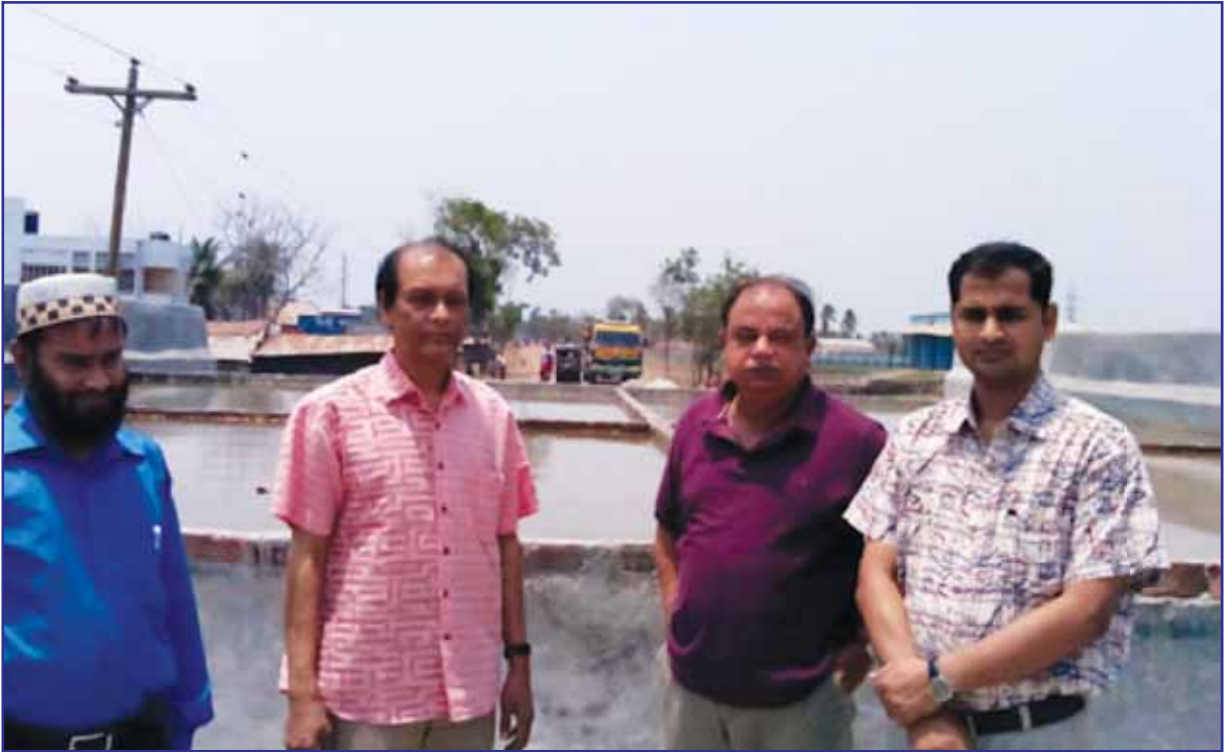
সড়ক পরিবহন ও মহাসড়ক বিভাগের মনিটরিং টিম-১৭ কর্তৃক খুলনা-চুকনগর-সাতক্ষীরা আঞ্চলিক মহাসড়কের নির্মাণাধীন কালভার্ট পরিদর্শন
