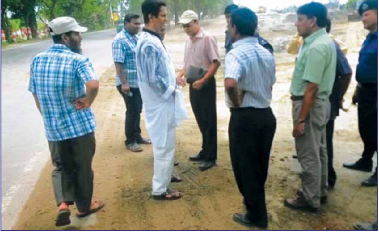
সড়ক পরিবহন ও মহাসড়ক বিভাগের অতিরিক্ত সচিব জনাব ফরিদ উদ্দিন আহম্মদ চৌধুরী জয়দেবপুর-টাঙ্গাইল-এলেন্সা মহাসড়ক ৪-লেনে উন্নীতকরণের কাজ পরিদর্শন করছেন
