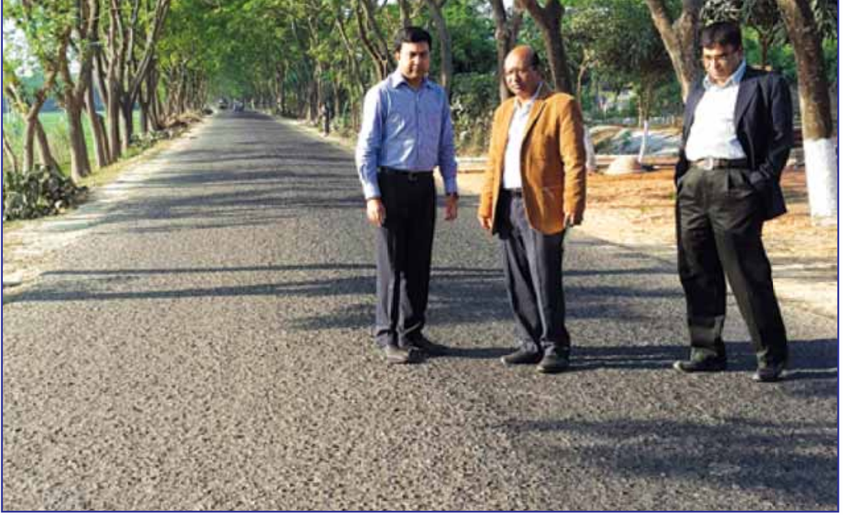
সড়ক পরিবহন ও মহাসড়ক বিভাগের মনিটরিং টিম-৬ কর্তৃক চাঁদপুর-লক্ষীপুর মহাসড়কে ডিবিএসটি কাজ পরিদর্শন
