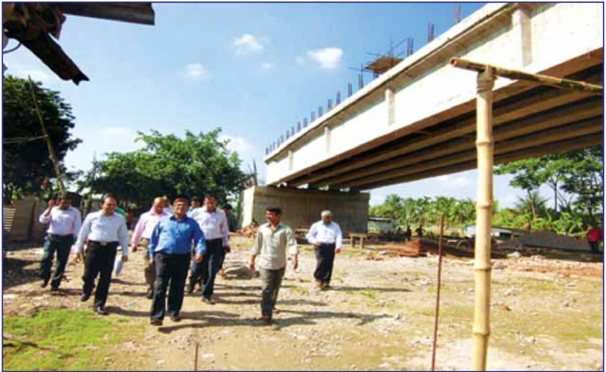
জনাব এম, এ, এন, ছিদ্দিক, সচিব, সড়ক পরিবহন ও মহাসড়ক বিভাগ শেখ লুৎফর রহমান সেতু (পাটগাতি সেতু) এর নির্মাণ কাজ পরিদর্শন করছেন।
