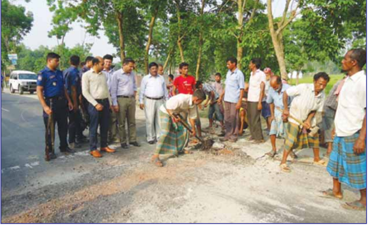
সড়ক পরিবহন ও মহাসড়ক বিভাগের মনিটরিং টিম-১৬ কর্তৃক দিনাজপুর-ঠাকুরগাঁও-পঞ্চগড় মহাসড়কের ঠাকুরগাঁও অংশে (চেইনেজ ৪৩০) স্পীডব্রেকার অপসারণ কাজ পরিদর্শন
