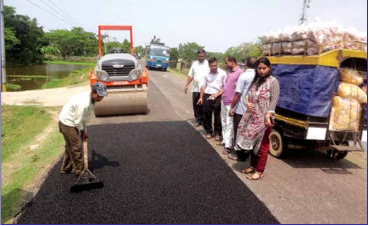
সড়ক পরিবহন ও মহাসড়ক বিভাগের মনিটরিং টিম-৮ কর্তৃক সিলেট-সুনামগঞ্জে আঞ্চলিক মহাসড়কের পিরিয়ডিক মেইনটেন্যান্স কাজ পরিদর্শন
