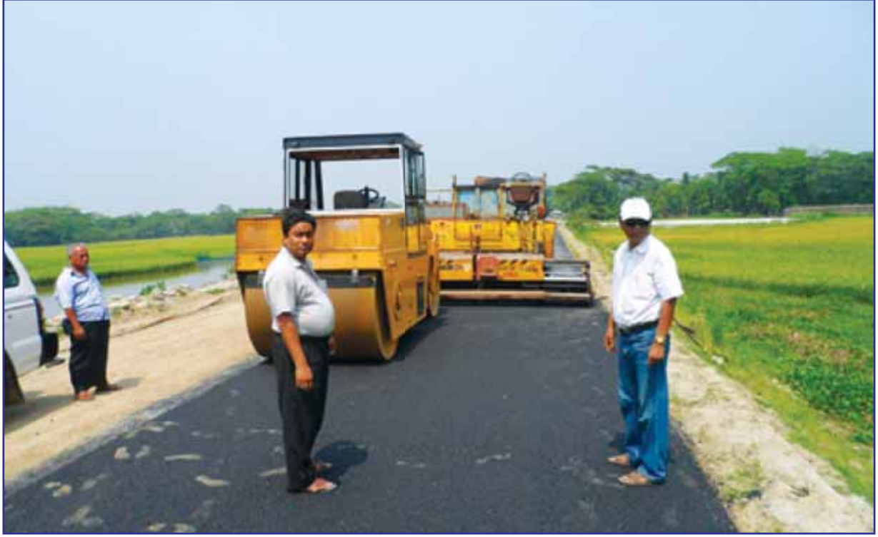
সড়ক পরিবহন ও মহাসড়ক বিভাগের মনিটরিং টিম-২০ কর্তৃক গৌরনদী-আগৈলঝাড়া-পয়সারহাট-কোটালীপাড়া-গোপালগঞ্জ মহাসড়কের উন্নয়ন কাজ পরিদর্শন
