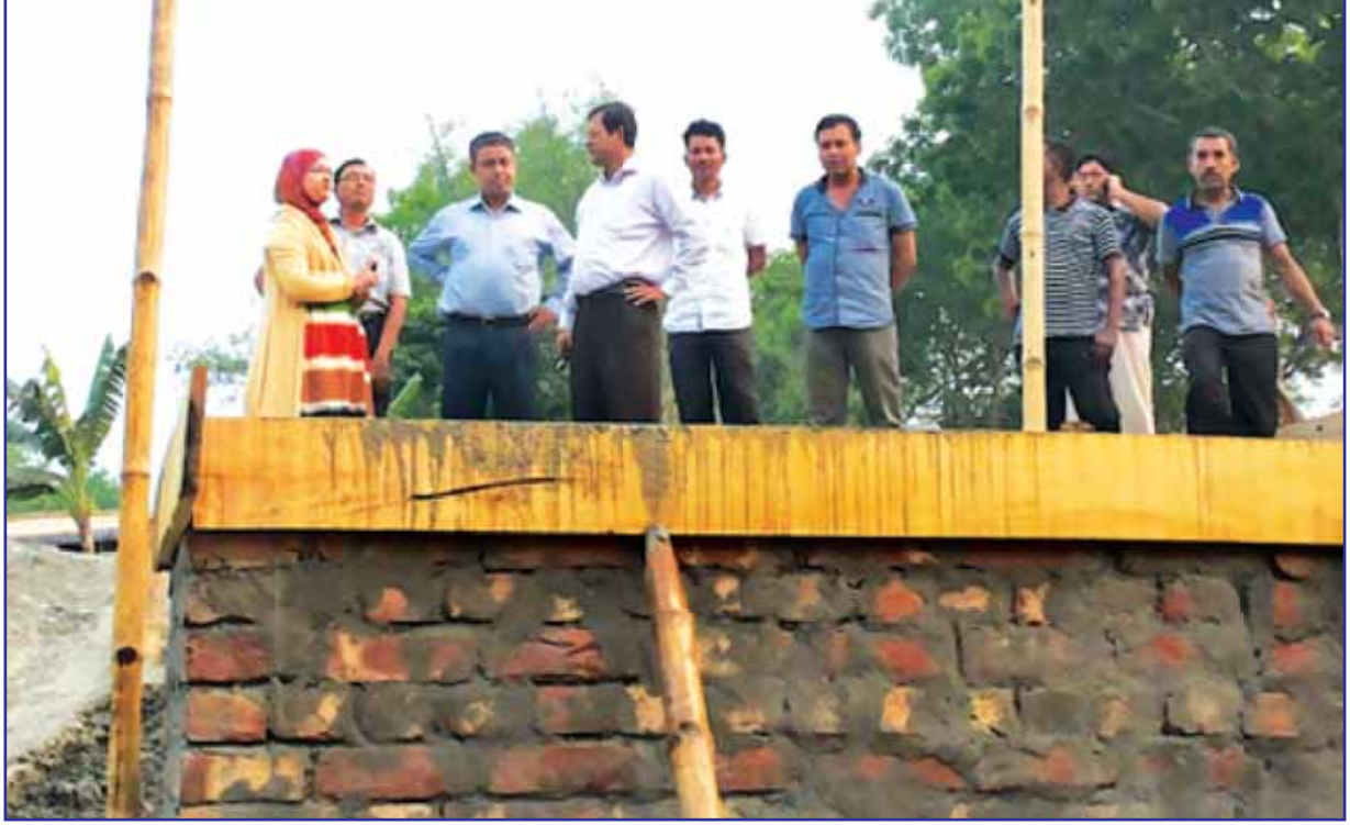
সড়ক পরিবহন ও মহাসড়ক বিভাগের মনিটরিং টিম-২৪ কর্তৃক তালমা-নগরকান্দা মহাসড়কের তালমা সেতু পুনর্নির্মাণ কাজ পরিদর্শন
