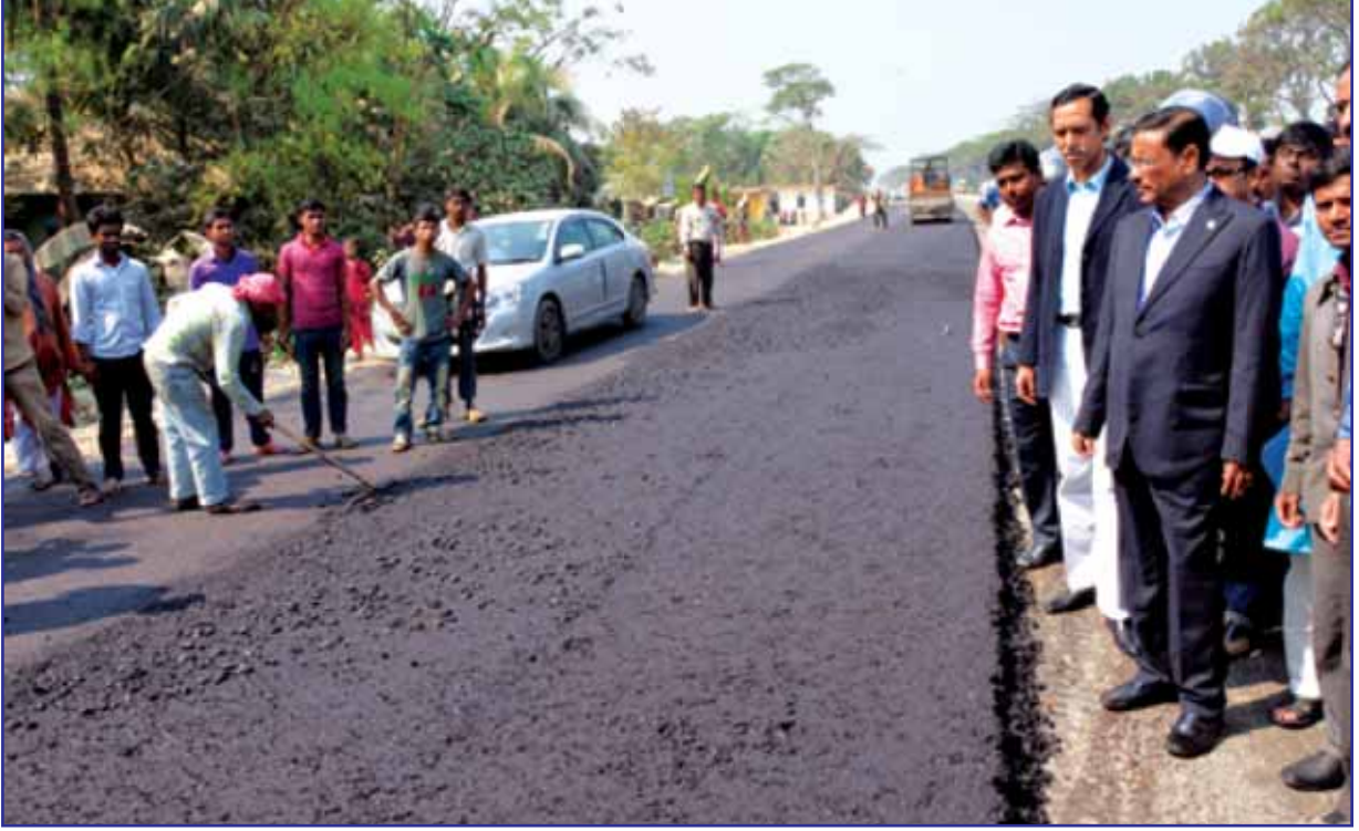
মাননীয় সড়ক পরিবহন ও সেতু মন্ত্রী জনাব ওবায়দুল কাদের ঢাকা-চট্টগ্রাম মহাসড়ক ৪-লেনে উন্নীতকরণের কাজ পরিদর্শন করছেন
