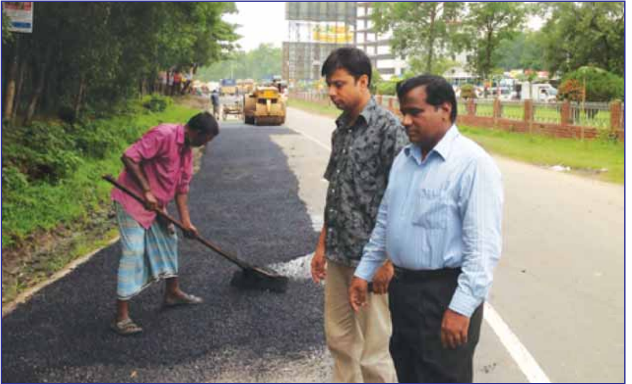
সড়ক পরিবহন ও মহাসড়ক বিভাগের মনিটরিং টিম-১১ কর্তৃক খাগড়াছড়ি-পানছড়ি সড়কের উন্নয়ন কাজ পরিদর্শন
