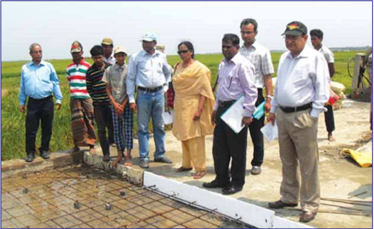
সড়ক পরিবহন ও মহাসড়ক বিভাগের মনিটরিং টিম-৫ কর্তৃক কিশোরগঞ্জ-করিমগঞ্জ-মিঠামইন সড়কের হাওড় এলাকায় সাবমার্জিবল সড়ক নির্মাণ কাজ পরিদর্শন
