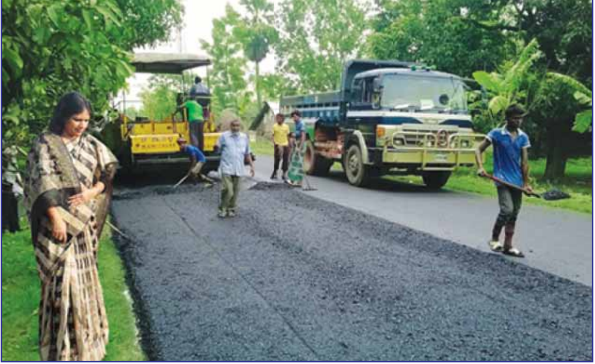
সড়ক পরিবহন ও মহাসড়ক বিভাগের মনিটরিং টিম-১২ কর্তৃক নবাবগঞ্জ-শিবগঞ্জ-কানসাট-সোনামসজিদ-বালিয়াদিঘী চেকপোস্ট সড়কে ডিবিএসটি ওভারলে কাজ পরিদর্শন
