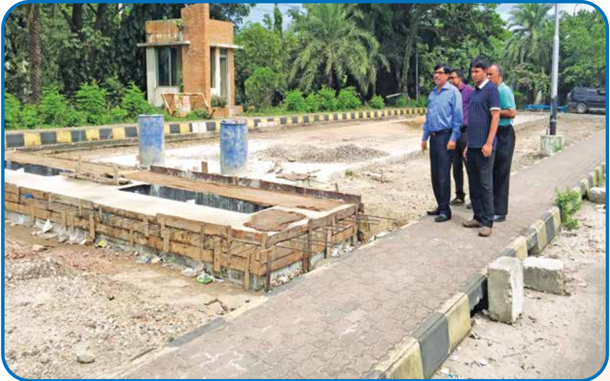
সড়ক পরিবহন ও মহাসড়ক বিভাগের অতিরিক্ত সচিব জনাব মোঃ ফারুক জলীল কর্তৃক মেঘনা টোল প্লাজা এলাকায় এক্সেল লোড কন্ট্রোল স্টেশন এর নির্মাণ কাজ পরিদর্শন
