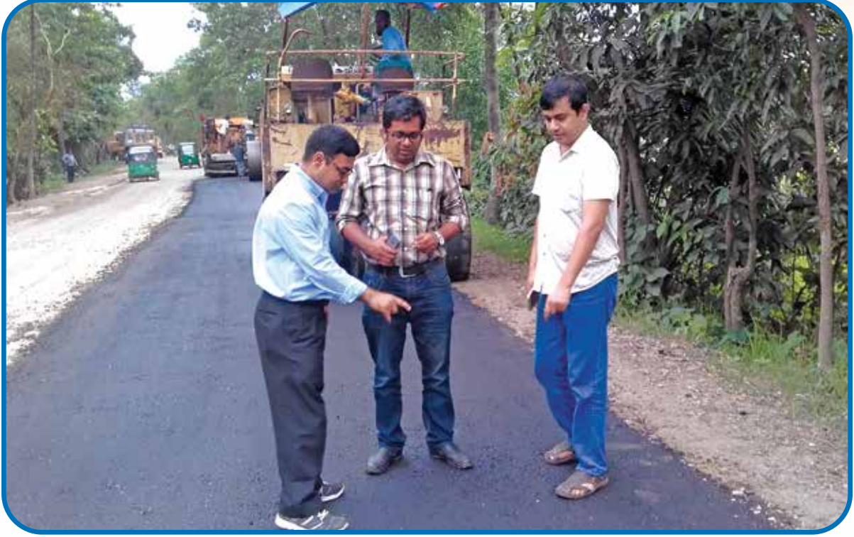
সড়ক পরিবহন ও মহাসড়ক বিভাগের মনিটরিং টিম-১০ এর প্রধান জনাব চন্দন কুমার দে ও সদস্যগণ কর্তৃক সিলেট-সুনামগঞ্জ মহাসড়কের উন্নয়ন কাজ পরিদর্শন
