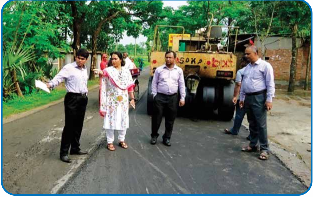
সড়ক পরিবহন ও মহাসড়ক বিভাগের মনিটরিং টিম-২৪ এর প্রধান তসলিমা কানিজ নাহিদা ও সদস্যগণ কর্তৃক জয়পুরহাট-পাঁচবিবি-হিলি মহাসড়কের মেরামত ও DBS Wearing Course এর কাজ পরিদর্শন
