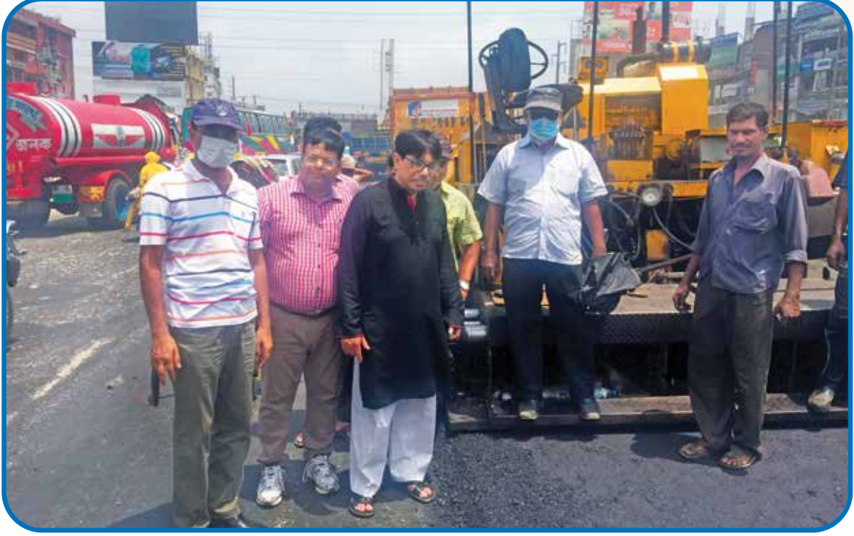
সড়ক পরিবহন ও মহাসড়ক বিভাগের অতিরিক্ত সচিব জনাব মোঃ ফারুক জলীল কর্তৃক যাত্রাবাড়ী-কাঁচপুর মহাসড়ক চ-লেনে উন্নীতকরণের কাজ পরিদর্শন
