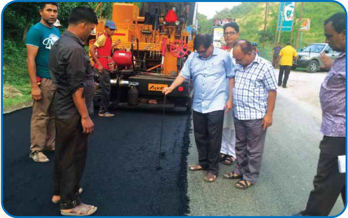
সড়ক পরিবহন ও মহাসড়ক বিভাগের অতিরিক্ত সচিব জনাব মোঃ ফারুক জলীল কর্তৃক চট্টগ্রাম-কাপ্তাই আঞ্চলিক মহাসড়কের পিএমপি কাজ পরিদর্শন
