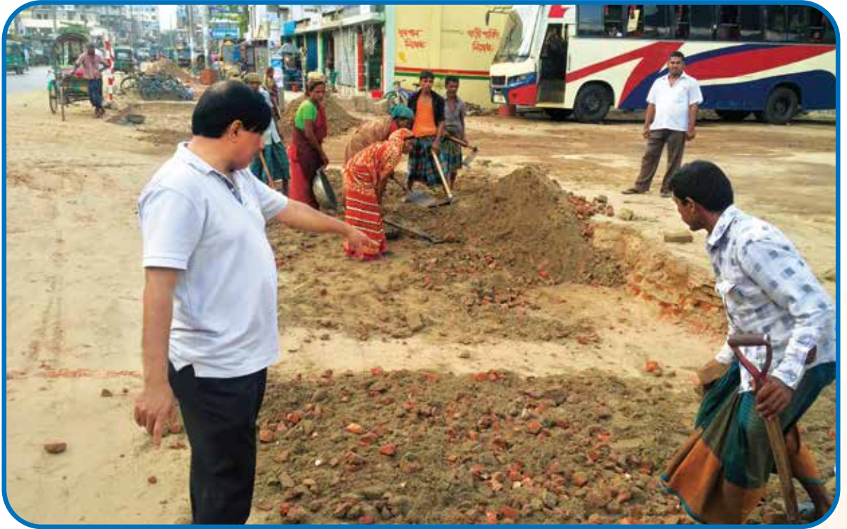
সড়ক পরিবহন ও মহাসড়ক বিভাগের অতিরিক্ত সচিব জনাব মোঃ ফারুক জলীল কর্তৃক চট্টগ্রাম অস্বিজেন মোড়-হাটহাজারী মহাসড়কের উন্নয়ন কাজ পরিদর্শন
