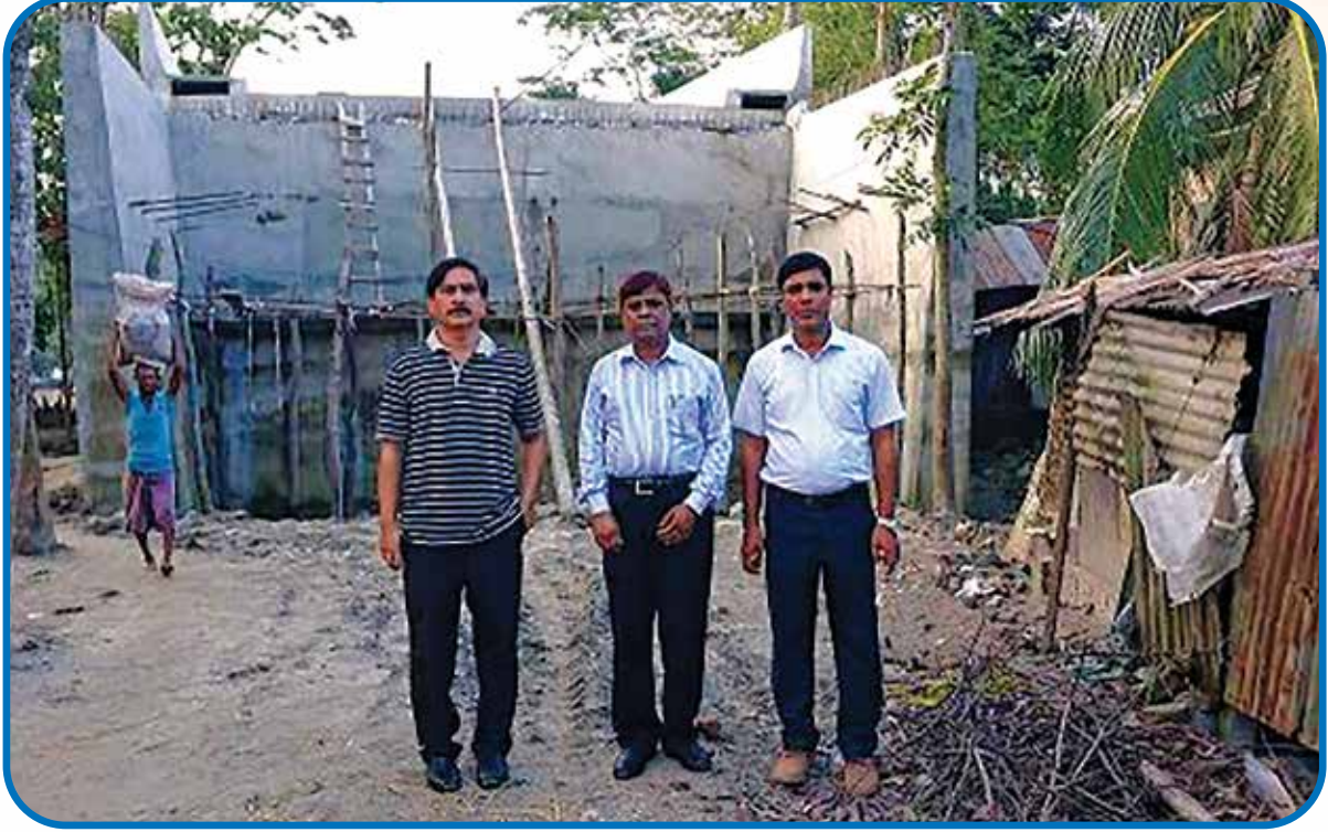
সড়ক পরিবহন ও মহাসড়ক বিভাগের মনিটরিং টিম-১৮ এর প্রধান জনাব মোঃ আব্দুল হামিদ ও সদস্যগণ কর্তৃক ঝালকাঠি সড়ক বিভাগে নির্মাণাধীন আমুয়া ব্রিজ এলাকা পরিদর্শন
