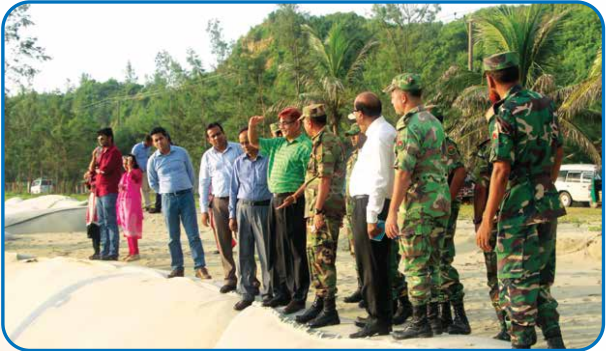
সড়ক পরিবহন ও মহাসড়ক বিভাগের সচিব কর্তৃক কক্সবাজার-টেকনাফ মেরিন ড্রাইভ-৩য় পর্যায় (সিলখালী-টেকনাফ-সাবরাং) প্রকল্পের কাজ পরিদর্শন
