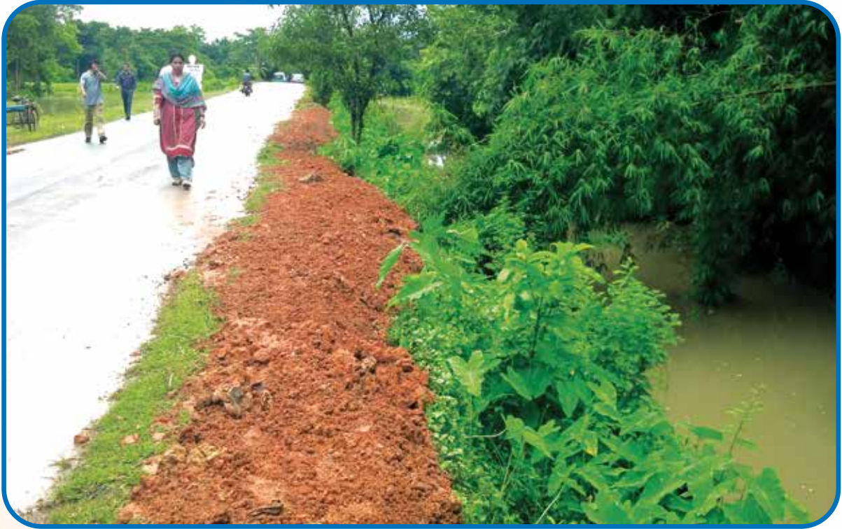
সড়ক পরিবহন ও মহাসড়ক বিভাগের মনিটরিং টিম-১১ এর প্রধান ড. সৈয়দা সালমা বেগম ও সদস্যগণ কর্তৃক রাজনগর-কুলাউড়া-জুরি-বড়লেখা-বিয়ানিবাজার-শেওলা-চরখাই মহাসড়কের কাজ পরিদর্শন
