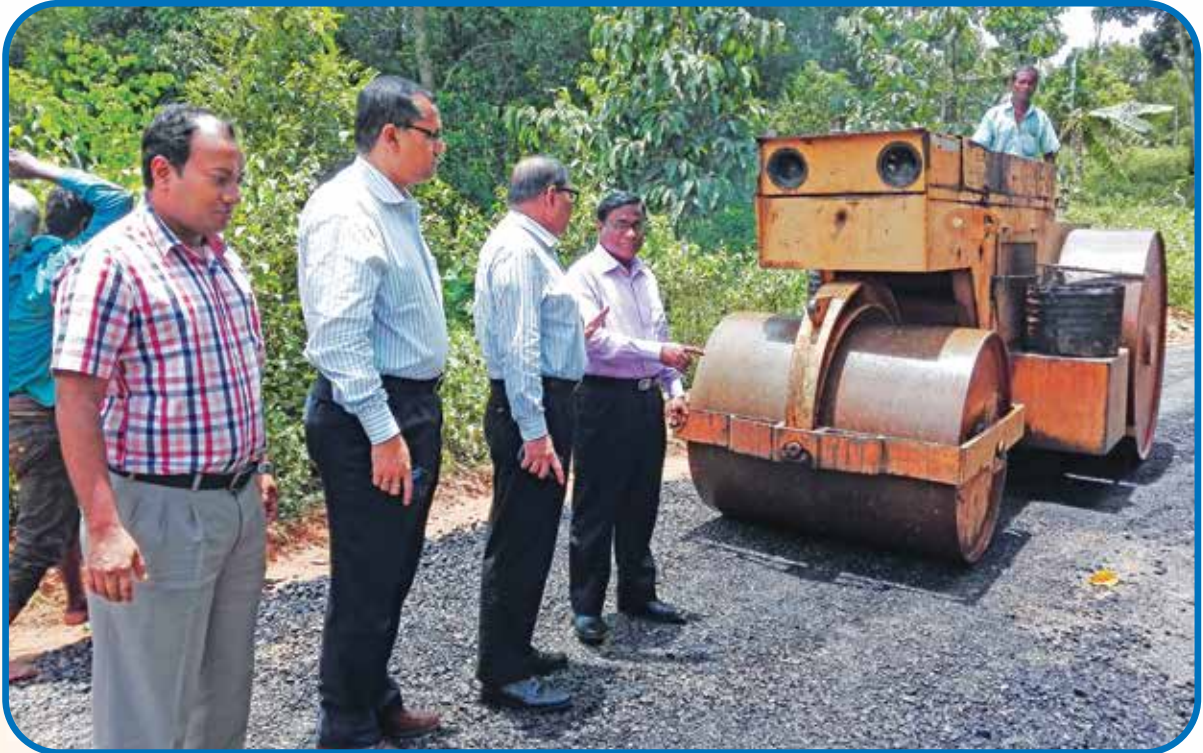
সড়ক পরিবহন ও মহাসড়ক বিভাগের মনিটরিং টিম-৭ এর প্রধান জনাব মোঃ আব্দুর রৌফ খান ও সদস্যগণ কর্তৃক খাগড়াছড়ি সড়ক বিভাগের আওতাধীন মাটিরাঙা-তানাক্কাপাড়া মহাসড়ক উন্নয়ন প্রকল্পের কাজ পরিদর্শন
