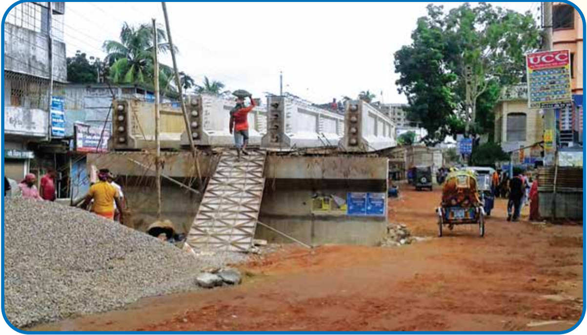
মৌড়াইল রেলওয়ে ওভারপাসের মূল স্ট্রাকচার এর নির্মাণ কাজ
