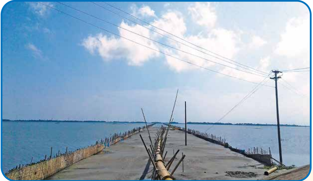
ইটনা-মিঠামইন-অষ্টগ্রাম মহাসড়কের চলমান নির্মাণ কাজ
