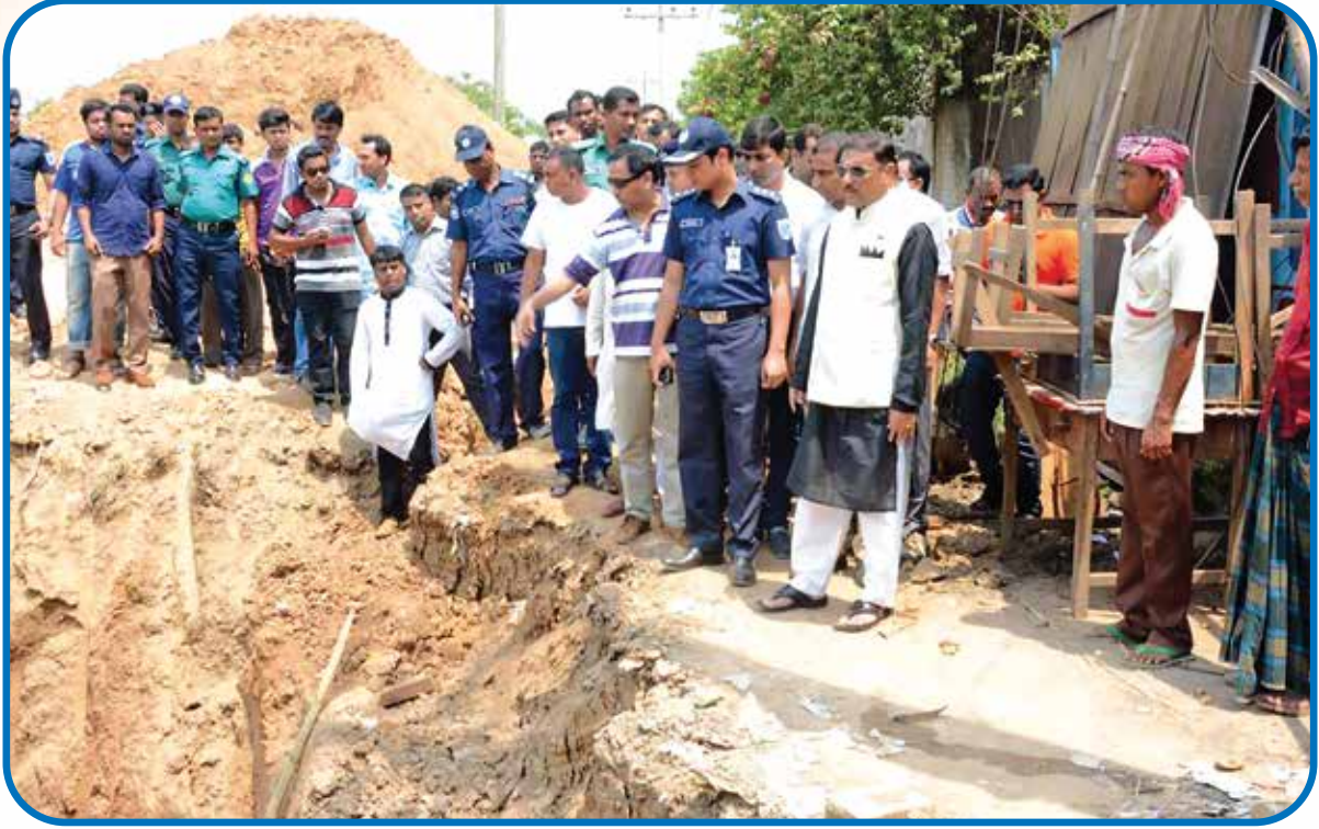
মাননীয় সড়ক পরিবহন ও সেতু মন্ত্রী জনাব ওবায়দুল কাদের কর্তৃক চন্দ্রা মোড়ের প্রশস্তকরণ কাজ পরিদর্শন
