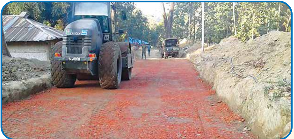
নির্মাণাধীন রুমা-বগালেক-কেওক্রাডং মহাসড়ক
