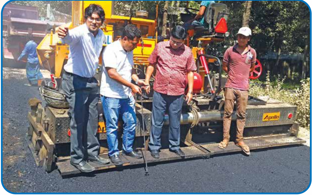
সড়ক পরিবহন ও মহাসড়ক বিভাগের মনিটরিং টিম-৮ এর প্রধান জনাব মোঃ আজহারুল ইসলাম খান কর্তৃক চট্টগ্রাম (অস্বিজেন মোড়)-হাটহাজারী মহাসড়কের নির্মাণ কাজ পরিদর্শন
