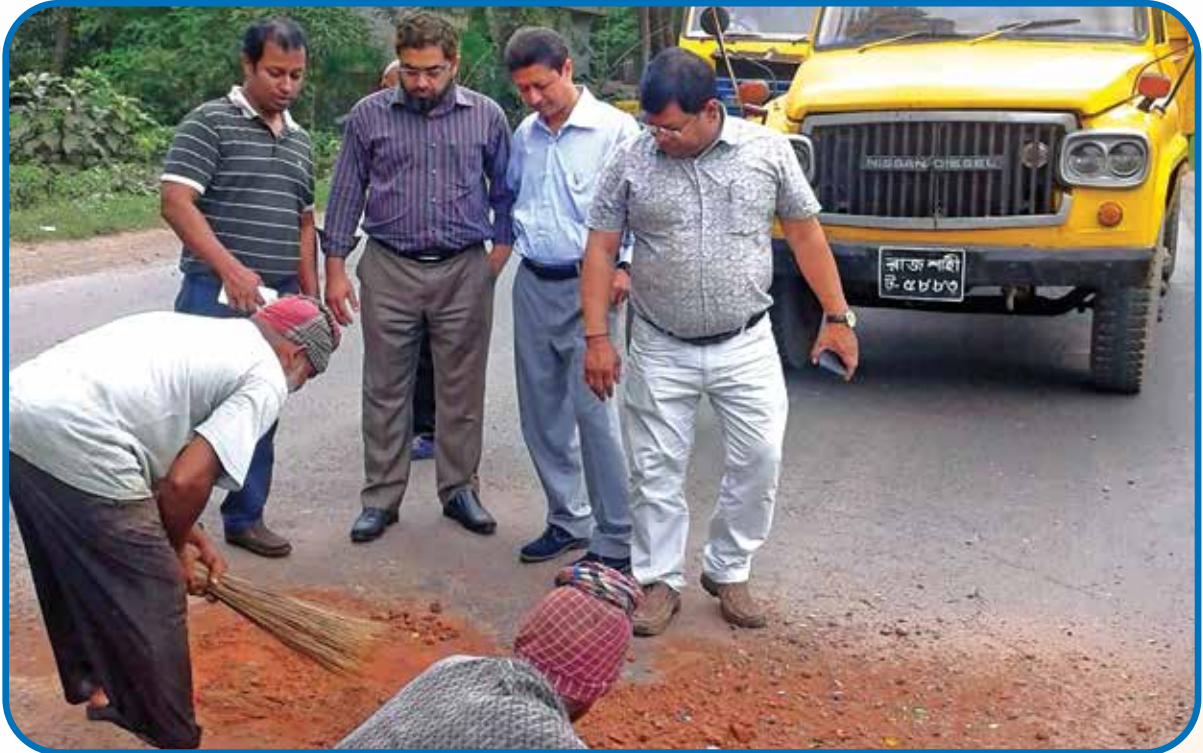
সড়ক পরিবহন ও মহাসড়ক বিভাগের মনিটরিং টিম-২১ এর প্রধান জনাব মোঃ এহছানে এলাহী ও সদস্যগণ কর্তৃক রাজশাহী বাইপাস মহাসড়কের মেরামত কাজ পরিদর্শন
