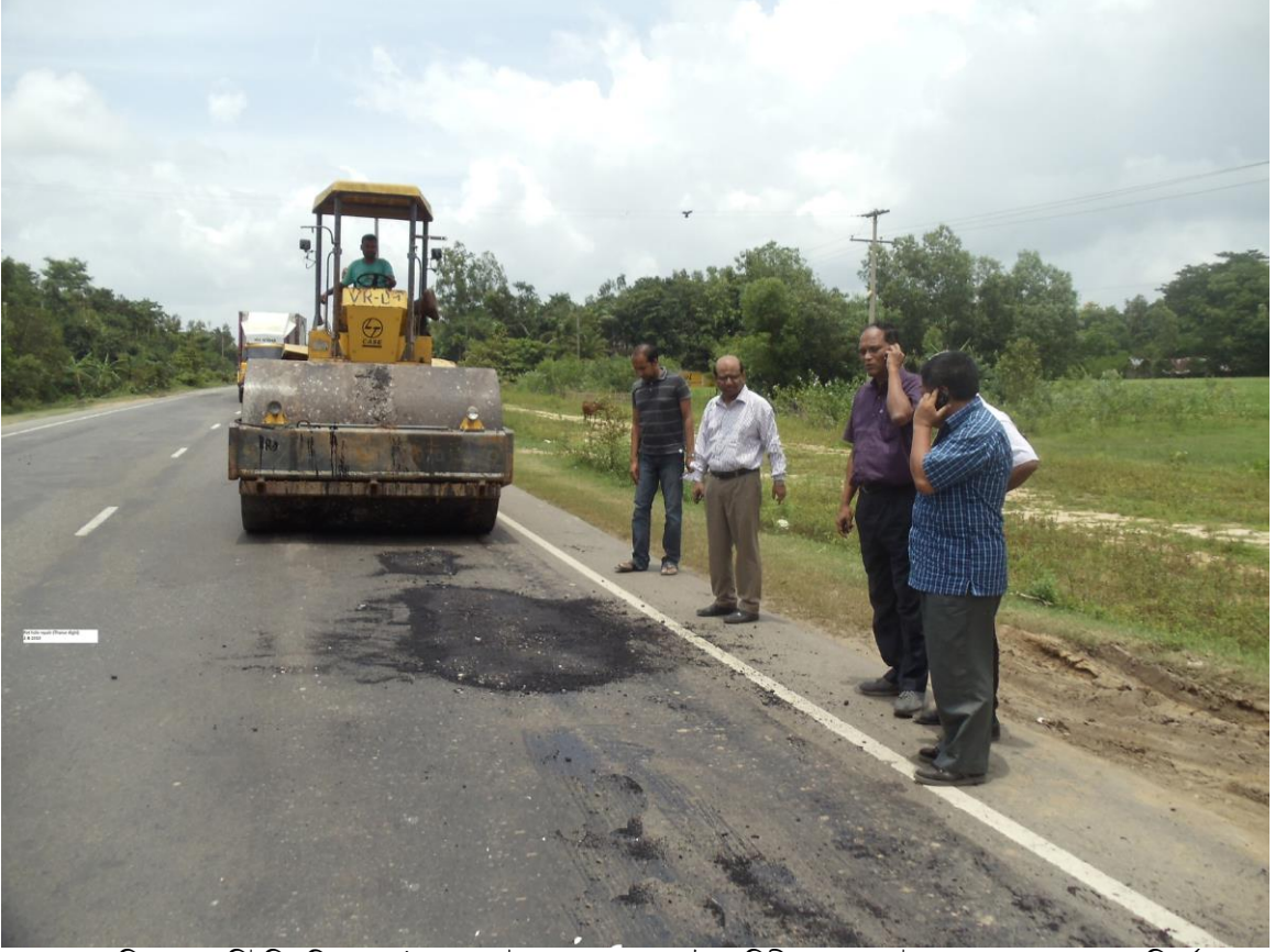
সড়ক বিভাগের মনিটরিং টিম-১ কর্তৃক ঢাকা-চট্টগ্রাম মহাসড়কের ঠাকুরদিঘী এলাকায় পটহোল্‌স মেরামত কাজ পরিদর্শন
