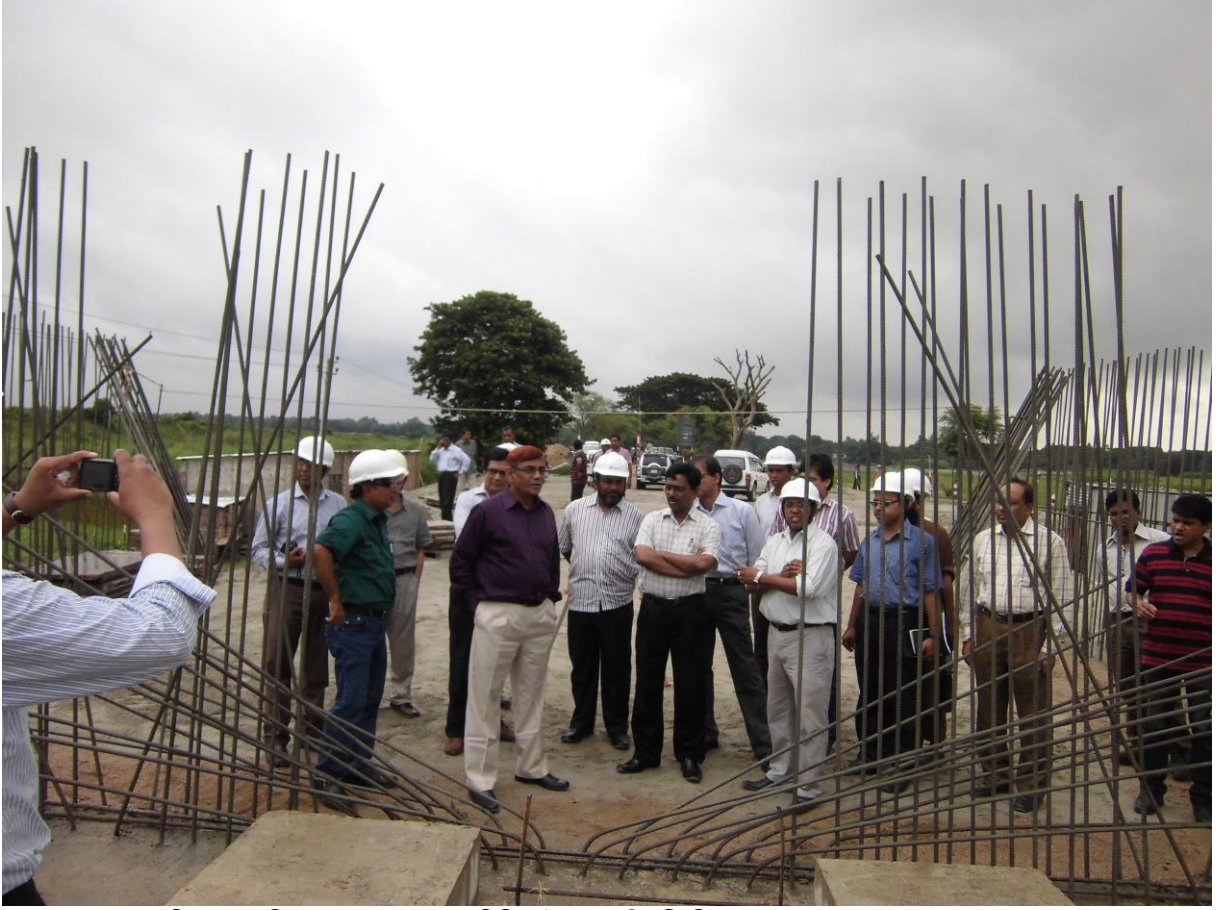
সড়ক বিভাগের সচিব জনাব এম, এ, এন, ছিদ্দিক ভৈরব-কটিয়াদী-কিশোরগঞ্জ সড়কে EBBIP প্রকল্পের আওতায় নির্মাণাধীন সেতু পরিদর্শন করছেন
