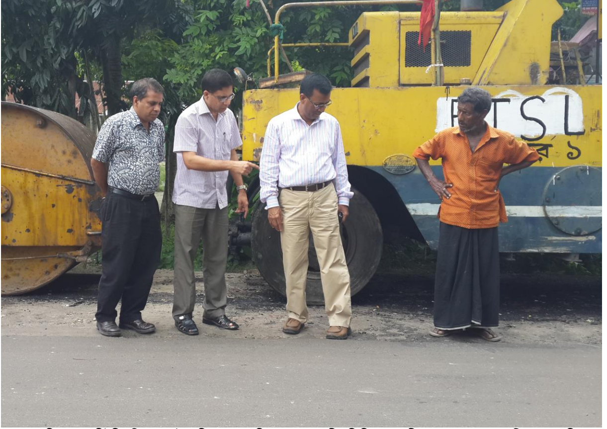
সড়ক বিভাগের মনিটরিং টিম-৫ কর্তৃক মুন্সিগঞ্জ সড়ক বিভাগের আওতাধীন জিজিরা-কেরানীগঞ্জ-নবাবগঞ্জ-দোহার-শ্রীনগর আঞ্চলিক মহাসড়কে পিএমপির আওতায় ওভালে কাজ পরিদর্শন
