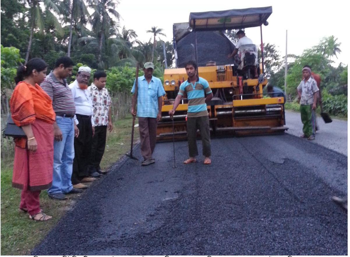
সড়ক বিভাগের মনিটরিং টিম-১৭ কর্তৃক বাগেরহাট সড়ক বিভাগের আওতাধীন নওয়াপাড়া-বাগেরহাট আঞ্চলিক মহাসড়কের ওভারলে কাজ পরিদর্শন
