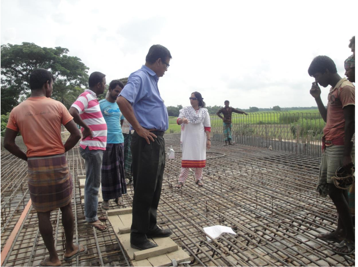
সড়ক বিভাগের মনিটরিং টিম-১২ কর্তৃক আরিচা-ঘিওর-দৌলতপুর-নাগরপুর-টাঙ্গাইল সড়কের ৪১ তম কিলোমিটারে আর.সি.সি. বক্স কালভার্ট এর নির্মাণ কাজ পরিদর্শন
