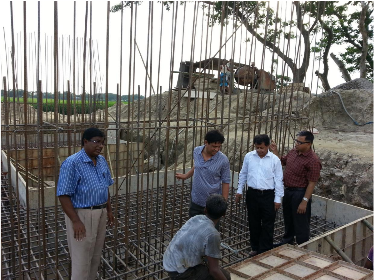
সড়ক বিভাগের মনিটরিং টিম-৪ কর্তৃক বান্ধগাড়ীয়া সড়ক বিভাগের অধীন কুমিল্লা (ময়নামতি)-ব্রাহ্মণবাড়ীয়া (সেরাইল বিশ্বরোড মোড়) মহাসড়কের মহিউদ্দিননগরে নির্মিতব্য সেতুর কাজ পরিদর্শন
