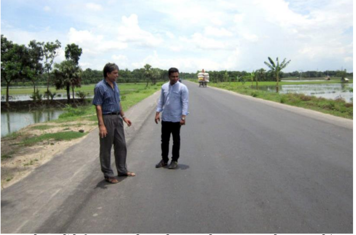
সড়ক বিভাগের মনিটরিং টিম-১৫ কর্তৃক সাতক্ষীরা সড়ক বিভাগের আওতাধীন খুলনা-চুকনগর-সাতক্ষীরা সড়কের পুনঃনির্মাণ কাজ পরিদর্শন
