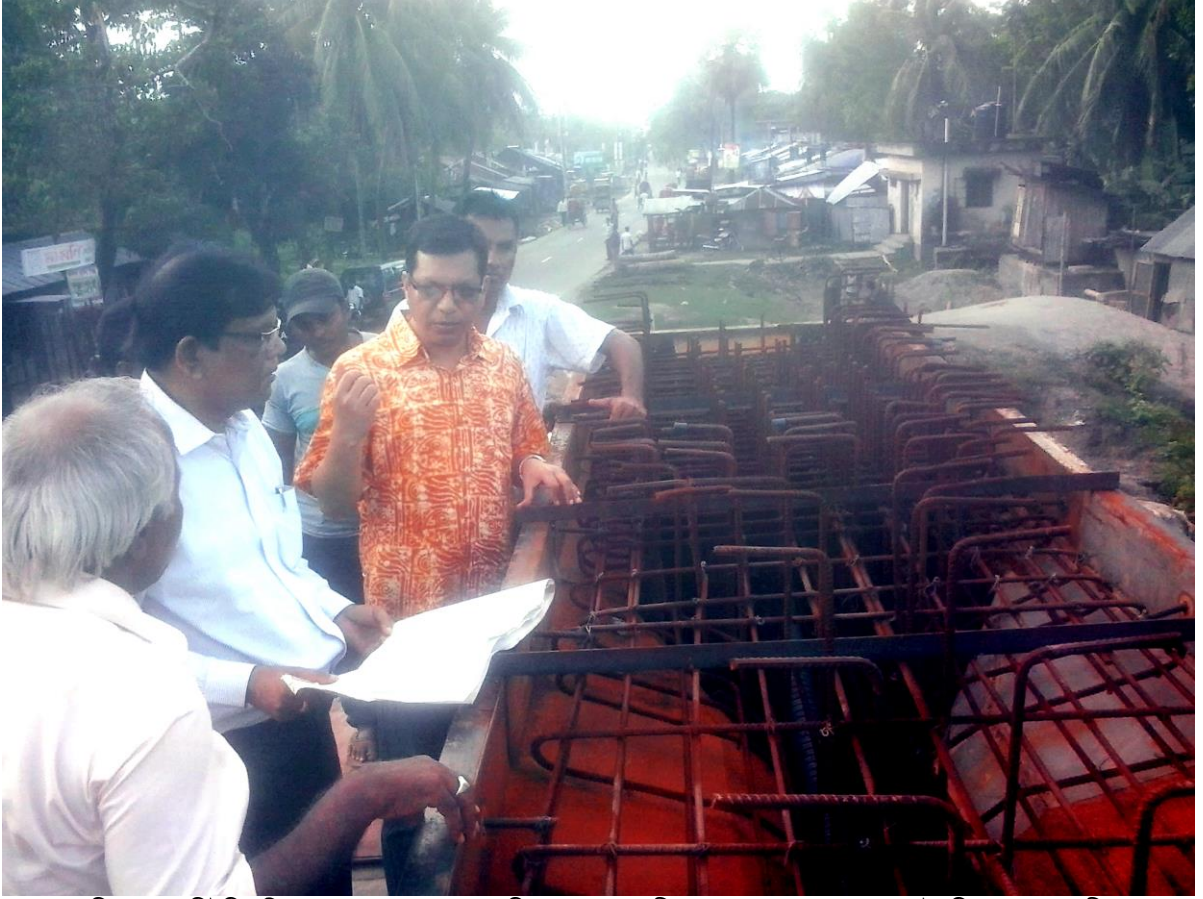
সড়ক বিভাগের মনিটরিং টিম-১৯ কর্তৃক ভোলা সড়ক বিভাগের আওতাধীন ভোলা-চরফ্যাশন সড়কের উপরিস্থ নাংগলখালী সেতুর নির্মাণ কাজ পরিদর্শন
