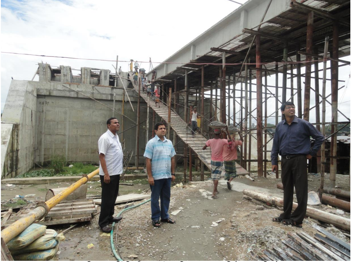
সড়ক বিভাগের মনিটরিং টিম-৯ কর্তৃক কাজিরবাজার সেতুর নির্মাণ কাজ পরিদর্শন
