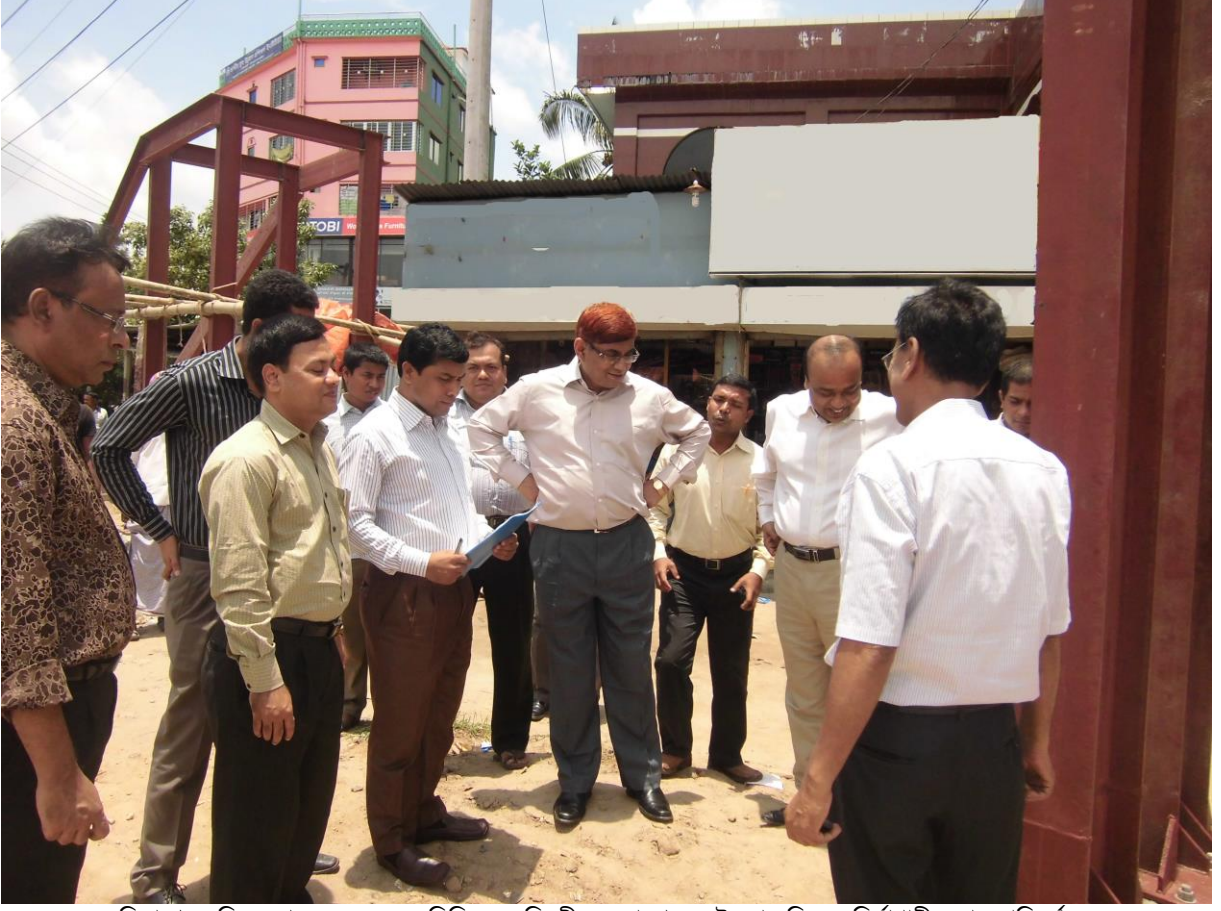
সড়ক বিভাগের সচিব জনাব এম, এ, এন, ছিদ্দিক নরসিংদীর ভেলানগরে ফুটওভার ব্রিজের নির্মাণাধীন কাজ পরিদর্শন করছেন
