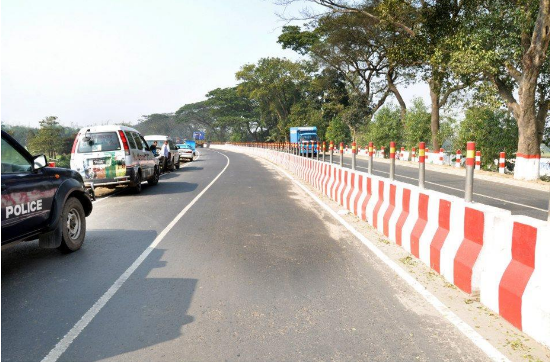
ঢাকা-আরিচা মহাসড়কে বাঁক সরলীকরণ ও ডিভাইডার স্থাপন
