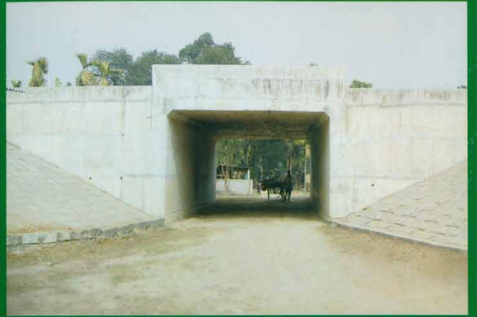
মহাসড়কে নবনির্মিত আভারপাস
