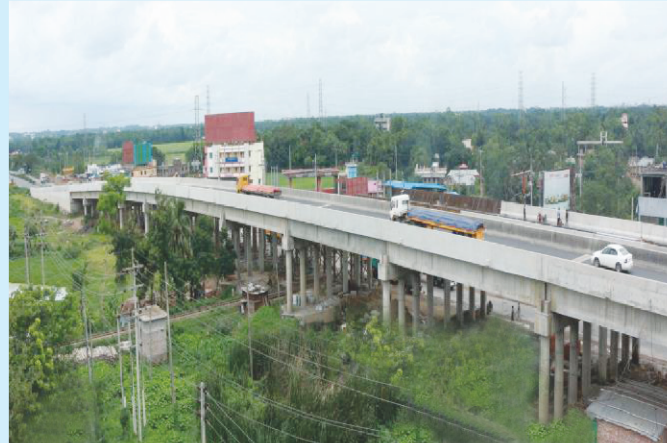
ঢাকা-চট্টগ্রাম মহাসড়কে নির্মিত কুমিল্লা রেলওয়ে ওভারপাস
